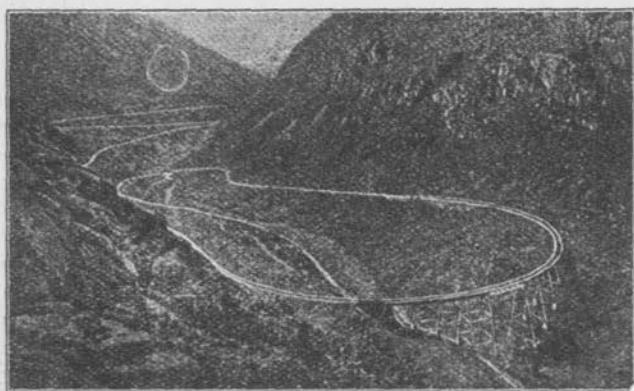
落機山中的高架鐵路
