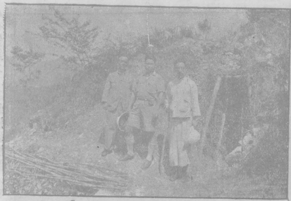
翁源楊家山錫鑛洞
