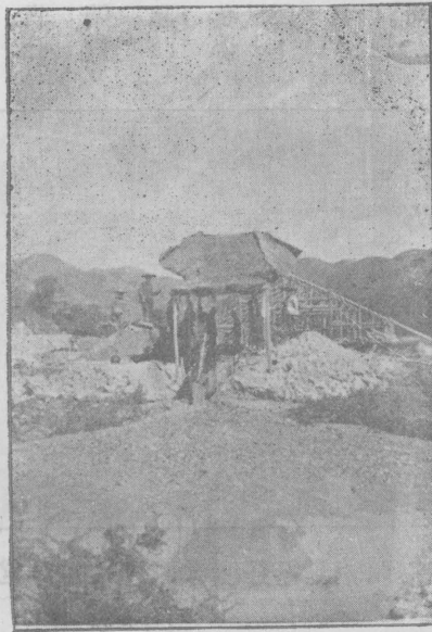
電白縣長徑河錫礦之淘礦槽
