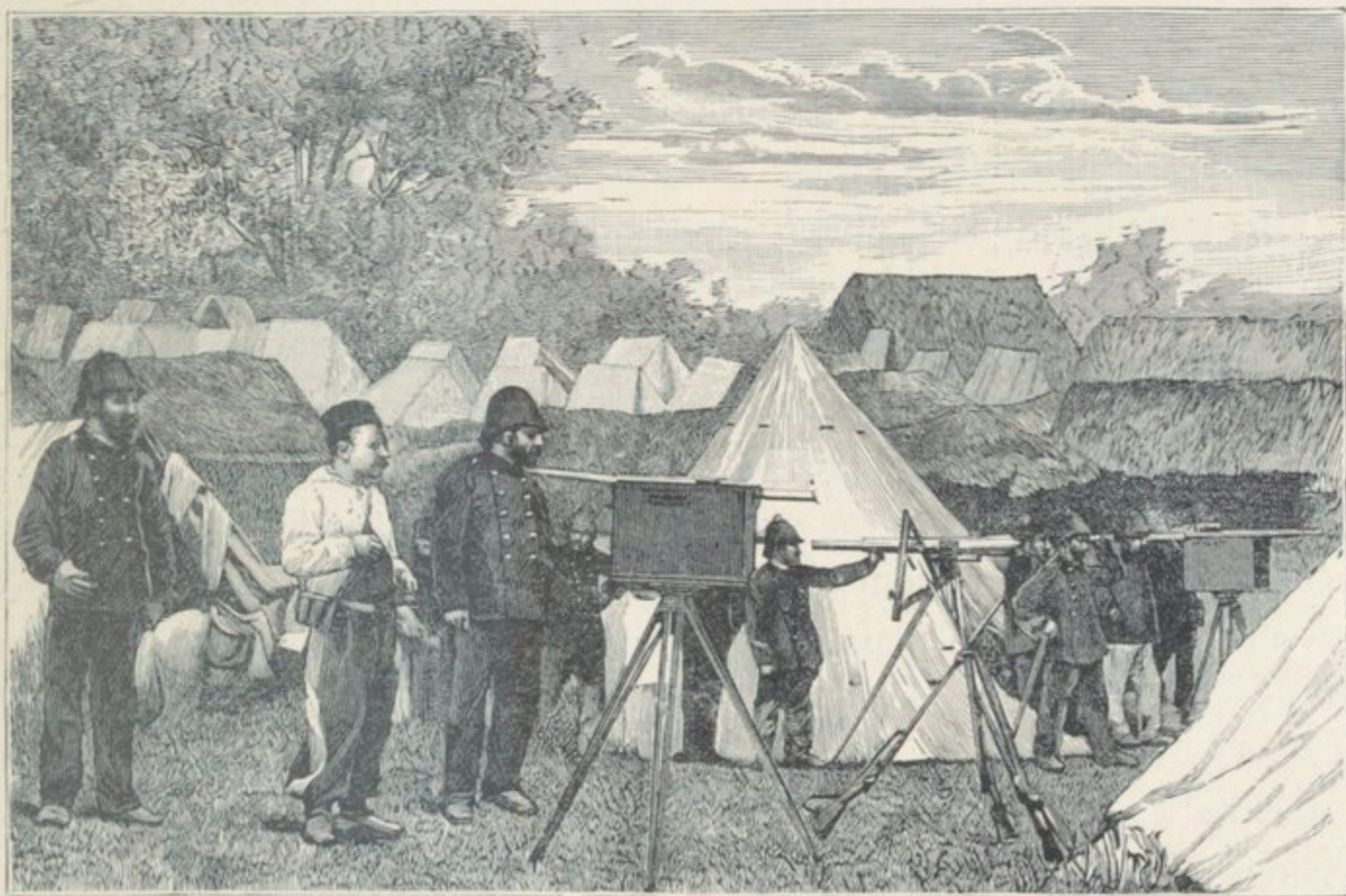
REVUE DES APPAREILS DE TÉLÉGRAPHIE OPTIQUE.
