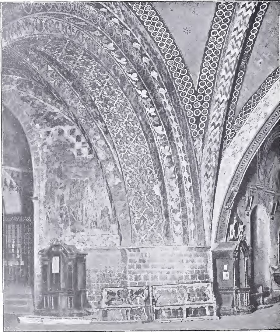
Abb. 10. Detail vom ersten Joch des unteren Langhauses in Assisi. (Phot. Alinari.)
