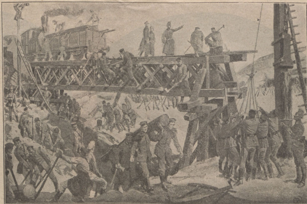
Наводка разрушенныхъ мостовъ германскими солдатами.
