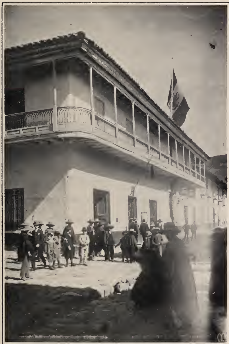
Casa donde funcionan la Prefectura, Corte y demás oficinas públicas en Cajamarca
