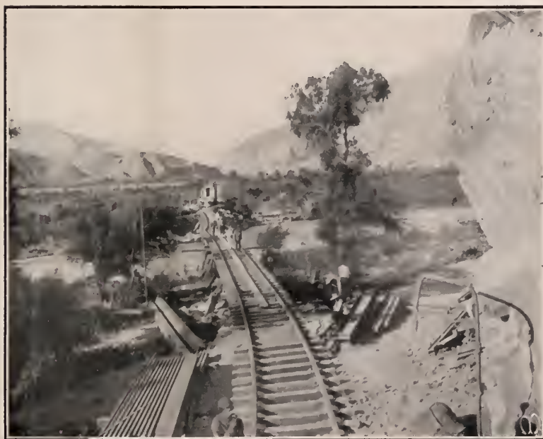
Ferrocarril de Yonán á Chilote.—Puente de Payoyoy
