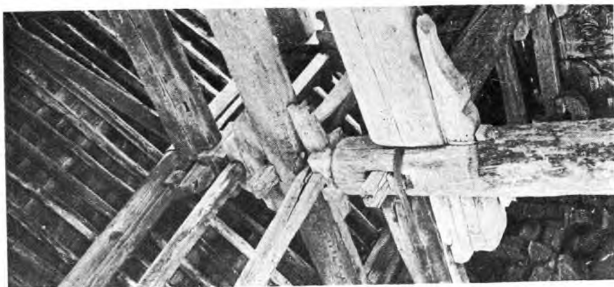
乙 正定陽和樓梁架
