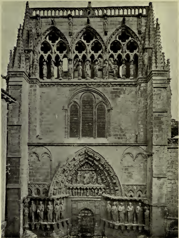
FACHADA DE LOS APÓSTOLES
