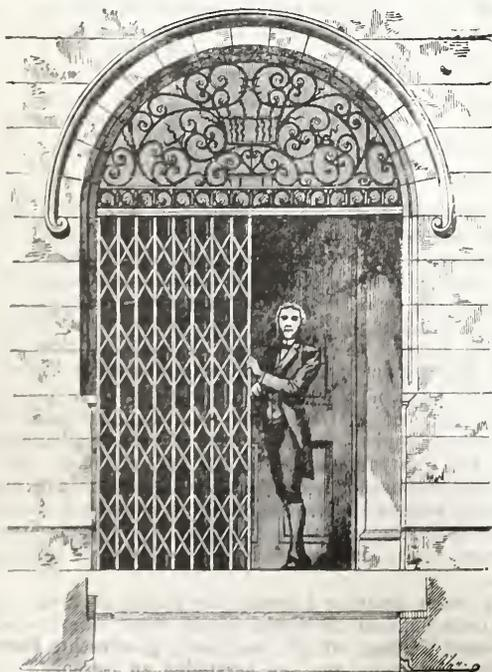
Die Schrägstäbe sind mit den Senkrechtstäben und eingelegten Futterungen, welche zur Fütterung der Scheeren innerhalb der Eisen dienen, beweglich vernietet.
