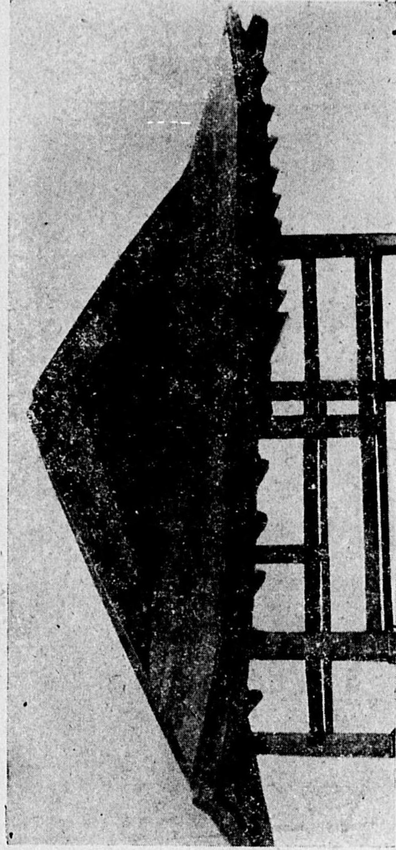
第 37 圖 (2) 起り破風入母屋の造り方 (その2)
