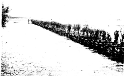
圖八 南二段第二道透水壩上游淤澱情形
