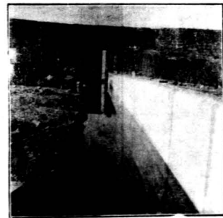
(十八)大壩完工後之前面
