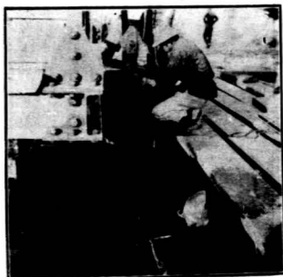
(二)打樁工程立鋼板樁(乙)
