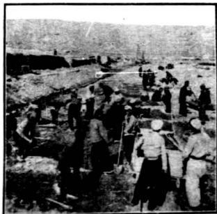
(五)挖土及打樁工程
