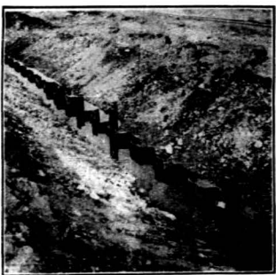
(四)已打好之鋼板樁(乙)
