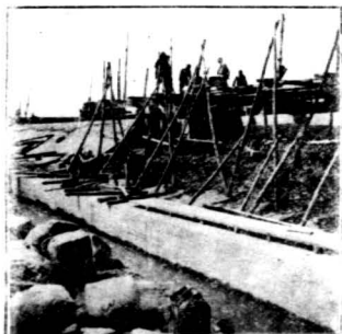
(十二)立第二層混凝土工作情形
