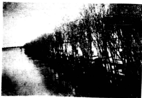
圖七 南二段第二道透水壩過水情形
