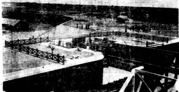
第五圖 船閘竣工攝影(三)
