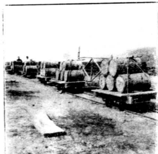
(十)運水泥小鐵車工作情形
