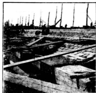
(十六)壩脚鉛絲籠碼砌片石工程
