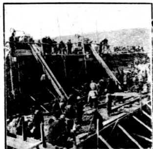
(九)大壩第一層混凝土工程(乙)
