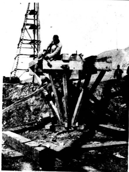
第三十二圖 荷重試驗木架攝影
