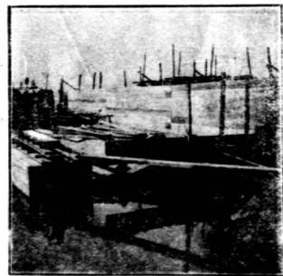
(十一)立第二層混凝土木型
