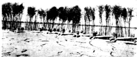
圖九 北三段透水壩掛淤情形
