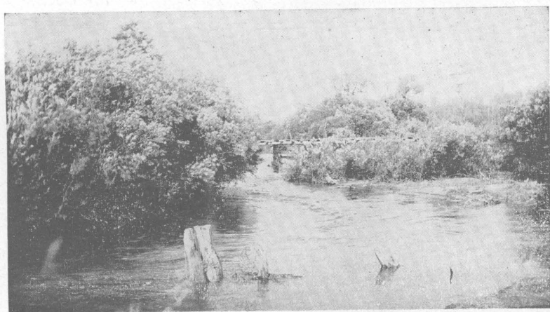
東鐵東線林場 跨蜻蜓河橋梁
