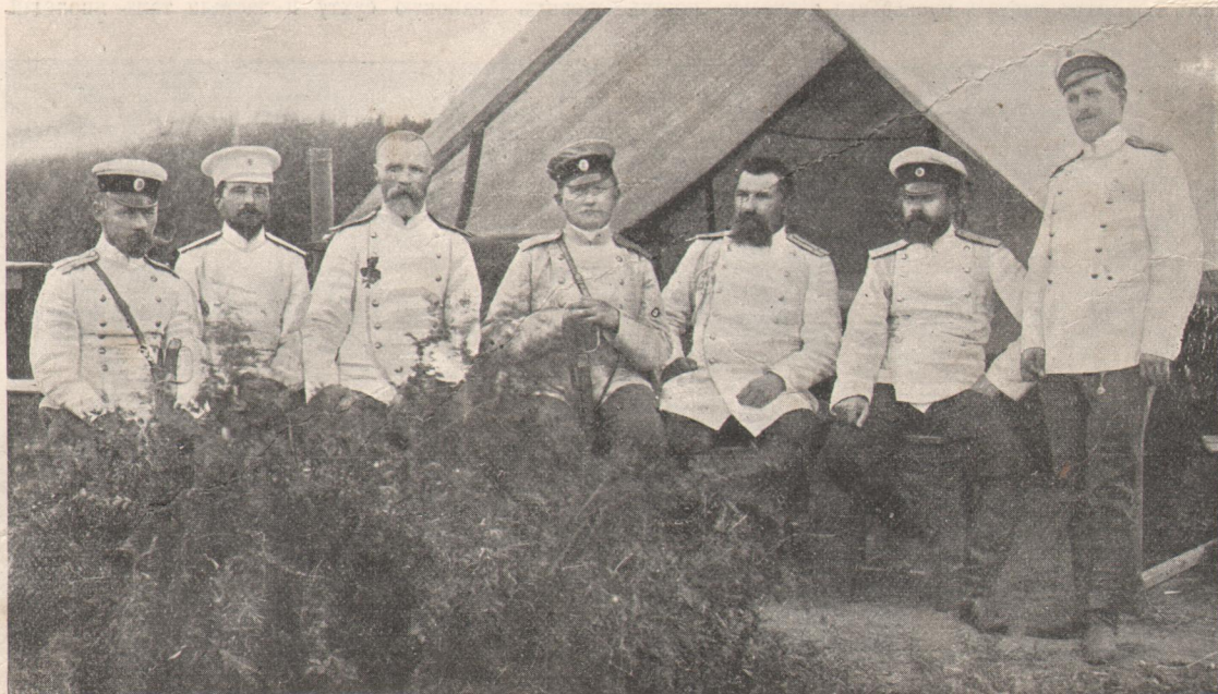
Начальникъ осадной артиллеріи генералъ Холодовскій съ офицерами мортирной бригады. По фот. авт. «Нивы».
