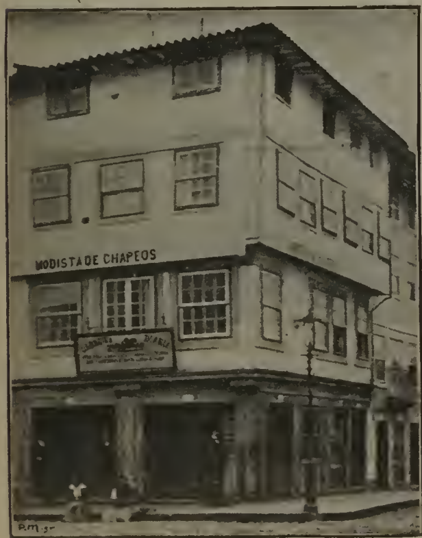
Fig. 8.—Casa n.º 1 da rua de S. Marcos—Braga
