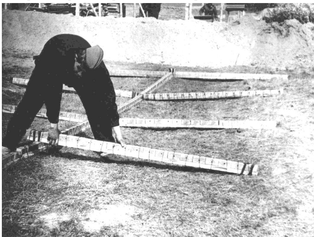
Фото №7. Изготовление и подготовка заряда для вскрытия бетонной подушки для шахтеров. Рядовой Д.В. Мельничук
