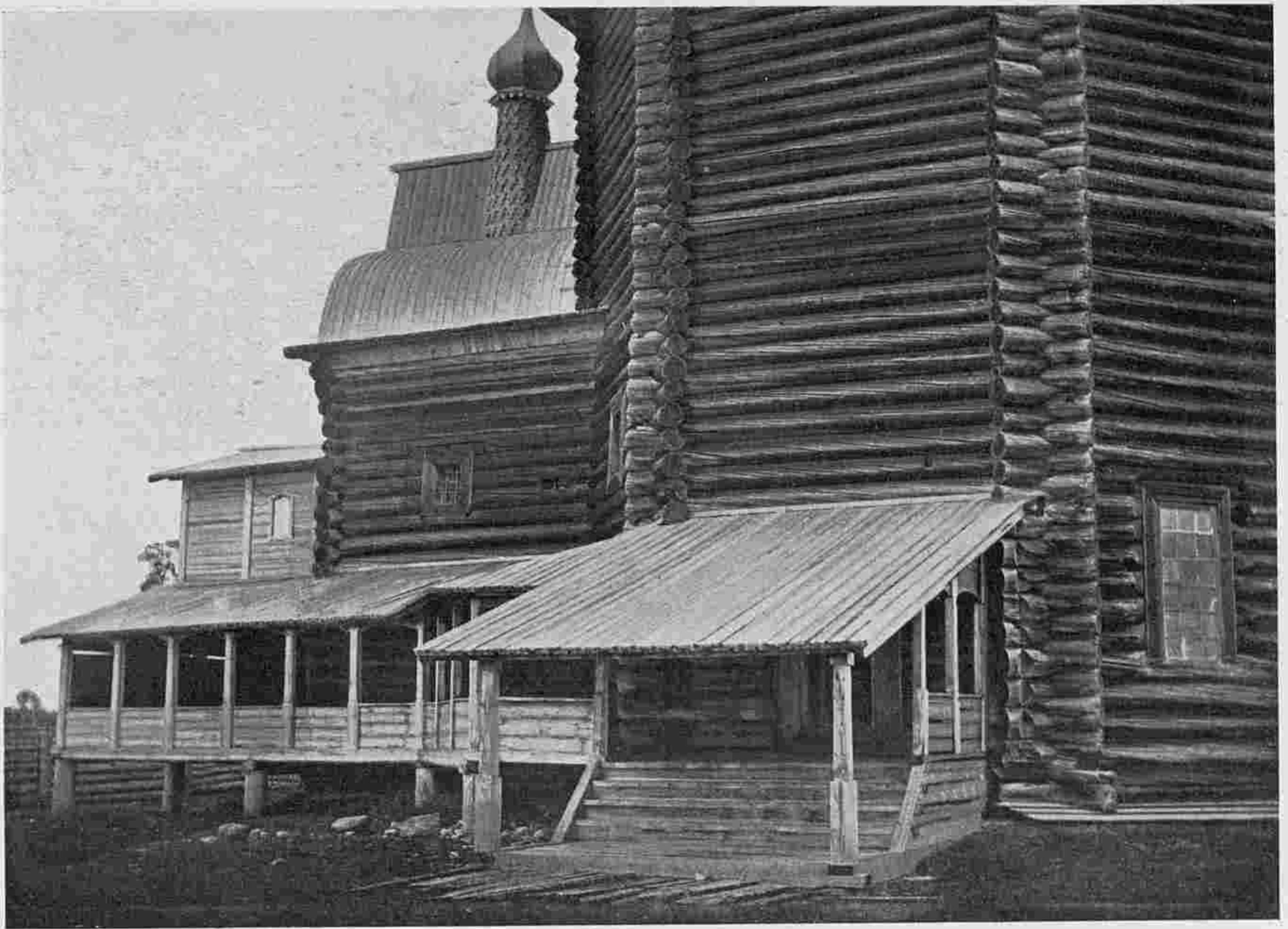
Деталь церкви въ Бѣлой Слудѣ (1642 г.). Détail de l'église à Biélaïa Slouda (district de Solvychégodsk).
