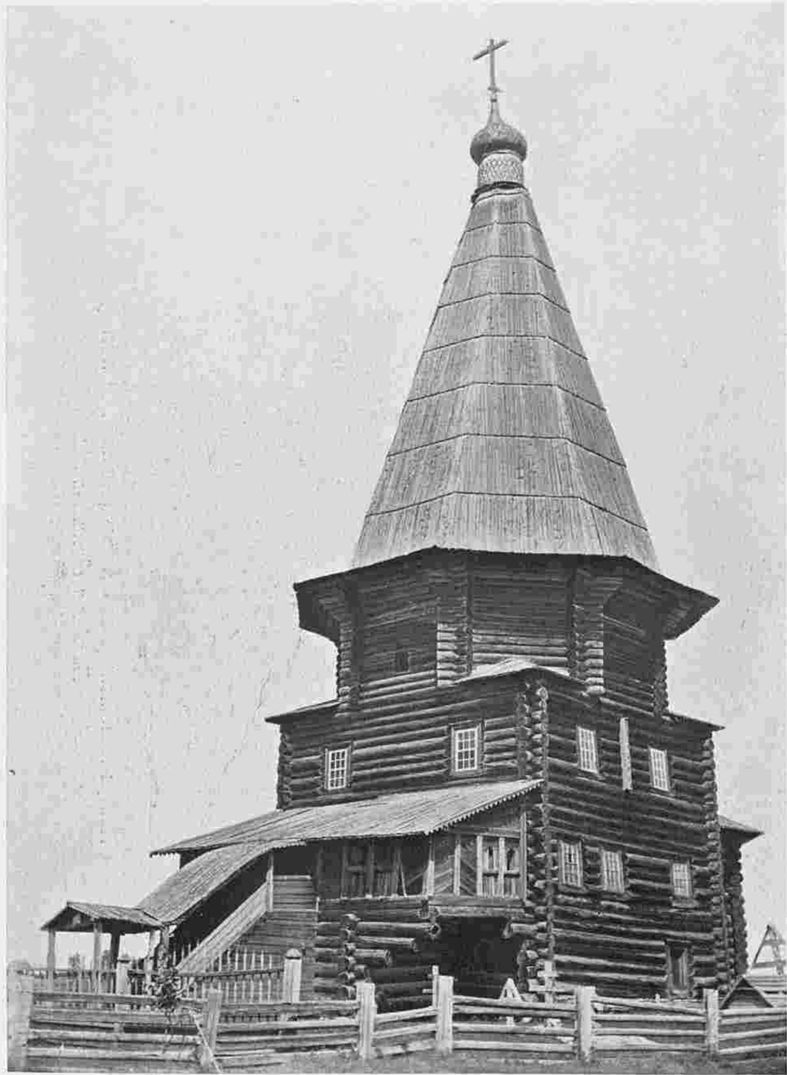
Церковь Верхняя Троица на Уфтюгъ (Сольвычегодскаго уѣзда), XVIII в. Прекрасно сохранилась безъ обшивки. Eglise de Verkhniaia Troïtza sur l'Ouftug (district de Solvytchégodsk). Conservée dans son état primitif.
