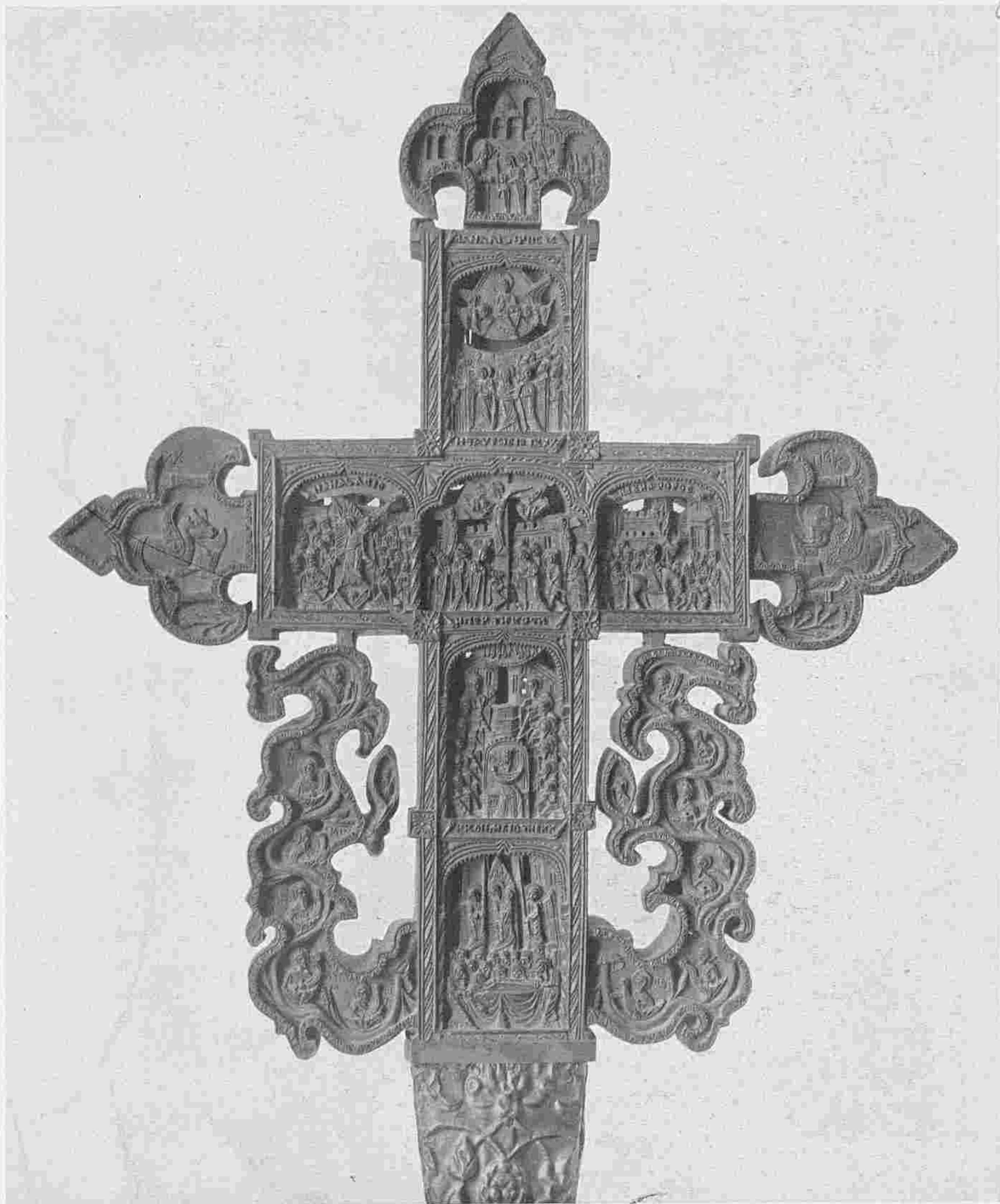
Деревянный крестъ на посохъ Аѳонской работы. Croix en bois sculpté surmontant un bâton d'évêque. Travail du mont Athos (XVII s.).
