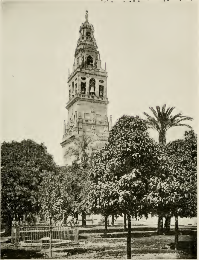
VIEW OF THE PATIO DE LOS NARANJOS.
