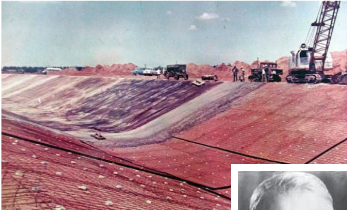
Будівництво Північно-Кримського каналу
