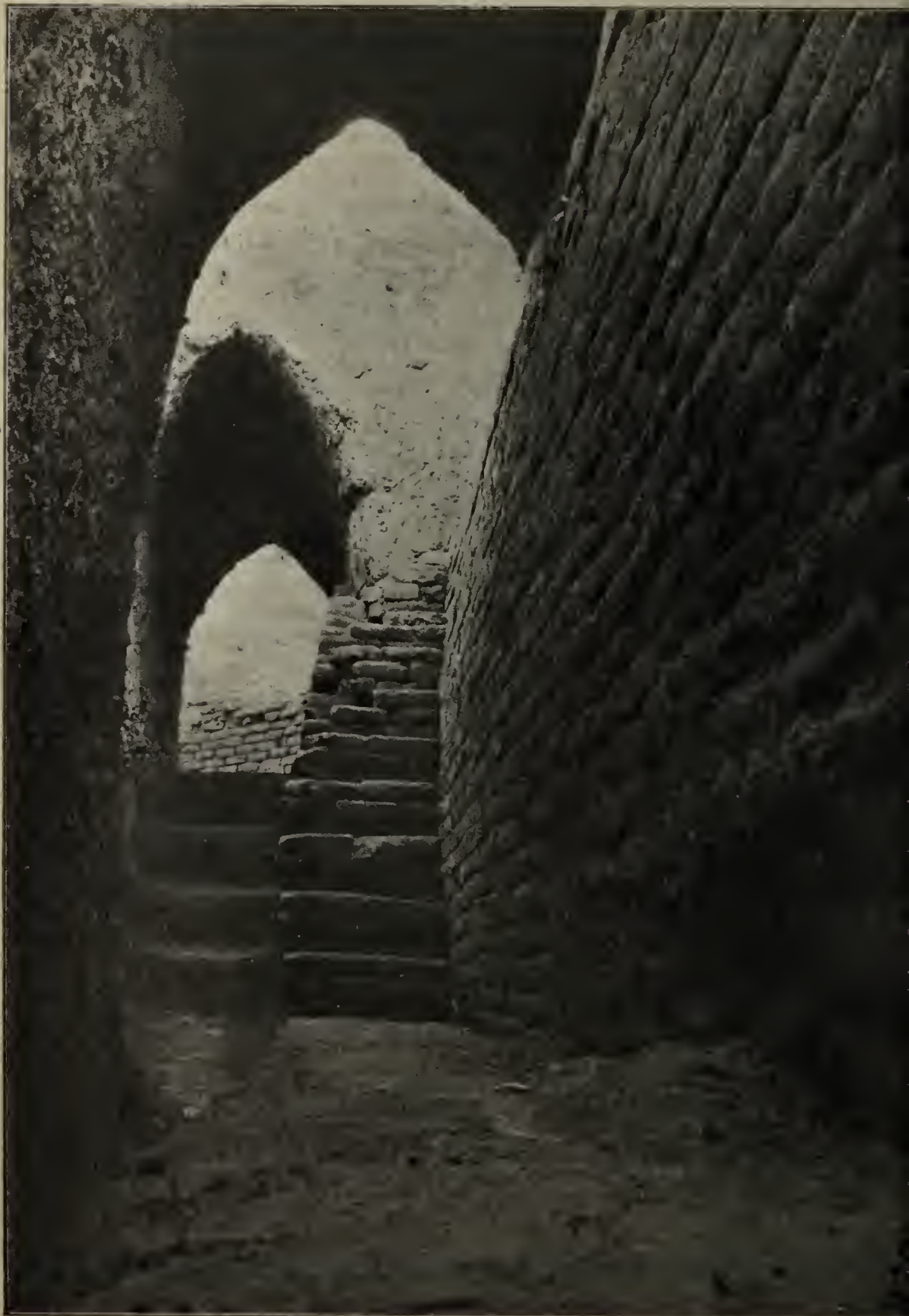
Abb. 3. Quaimauer an der Südostecke des Kosr mit Bootanlegestelle (Podest mit Treppe).
