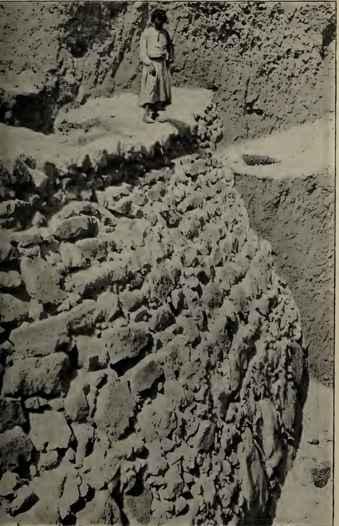
Abb. 7. Fundament der Stadtmauer im Graben I, von Nordosten aus.
