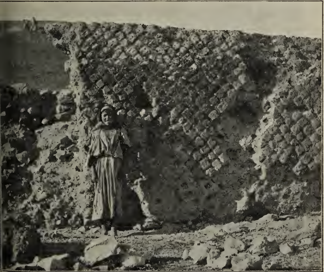
Abb. 15. Mauer aus Gußwerk mit Retikulatverkleidung.
