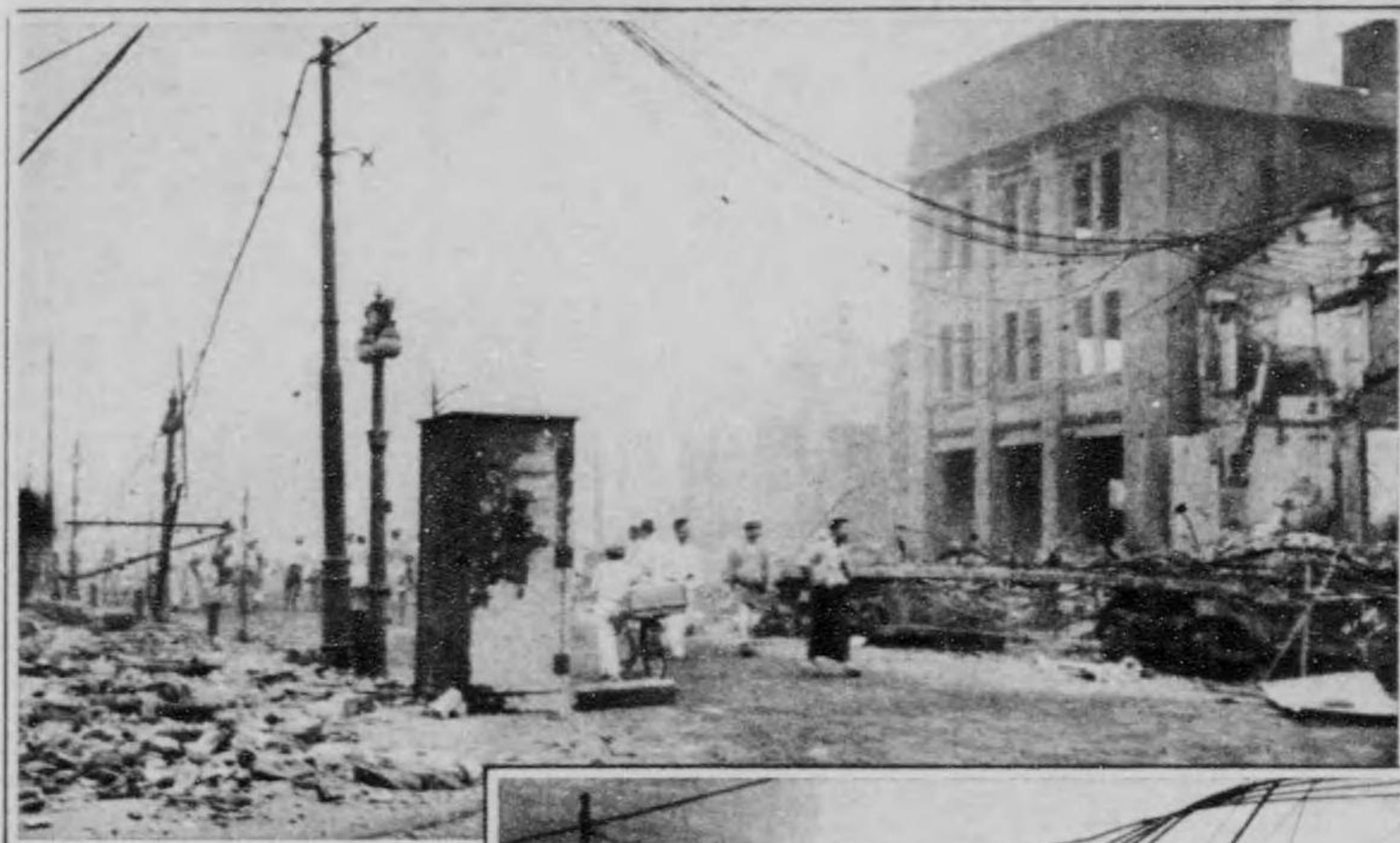
亂垂した架空電線 日本橋區内
