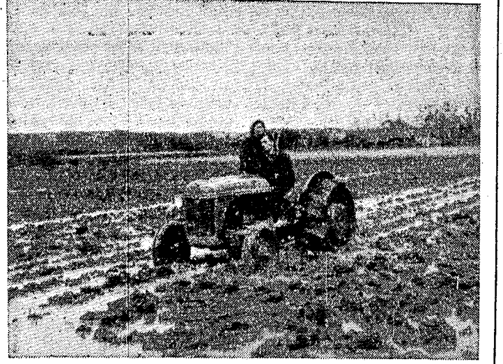
常德拖拉機站正式為農業社耕種了。這是用改裝的福特水田犁，幫助來社代耕水田，每個工作班（10小時）可耕水田60畝。圖為拖拉機手和實習生在進行春耕的情形。（瀘溪報供稿）
