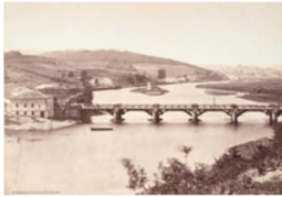
Puente de Behobia - Irun
