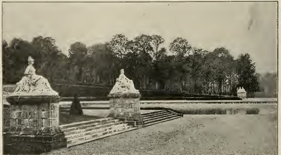
Abb. 12. Dekorative Treppenanlage in Vaux le Vicomte.
