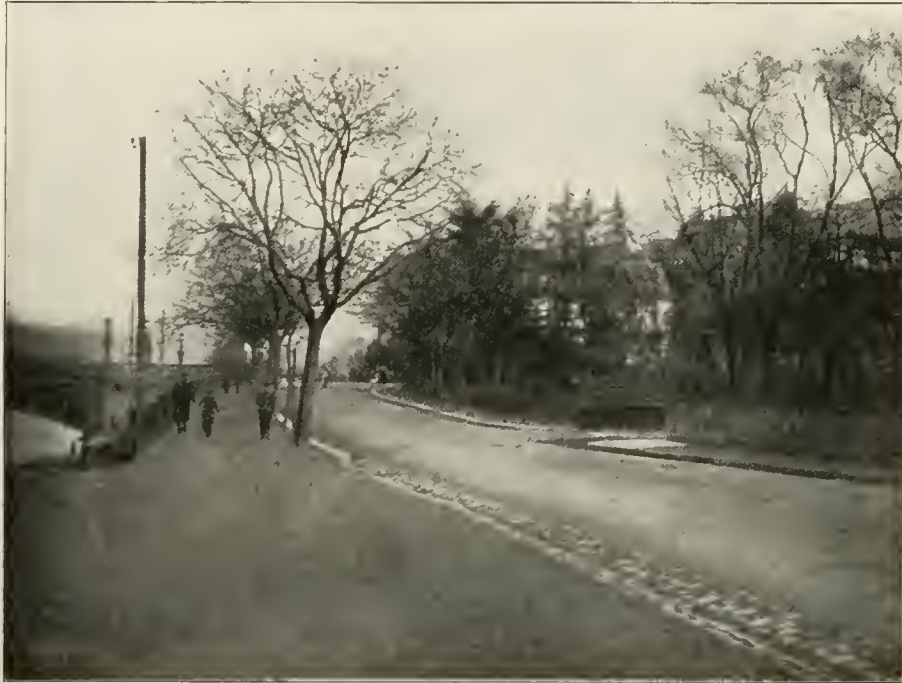
Abb. 5. Brückenkopf beim Bismarckplatz in Heidelberg.
