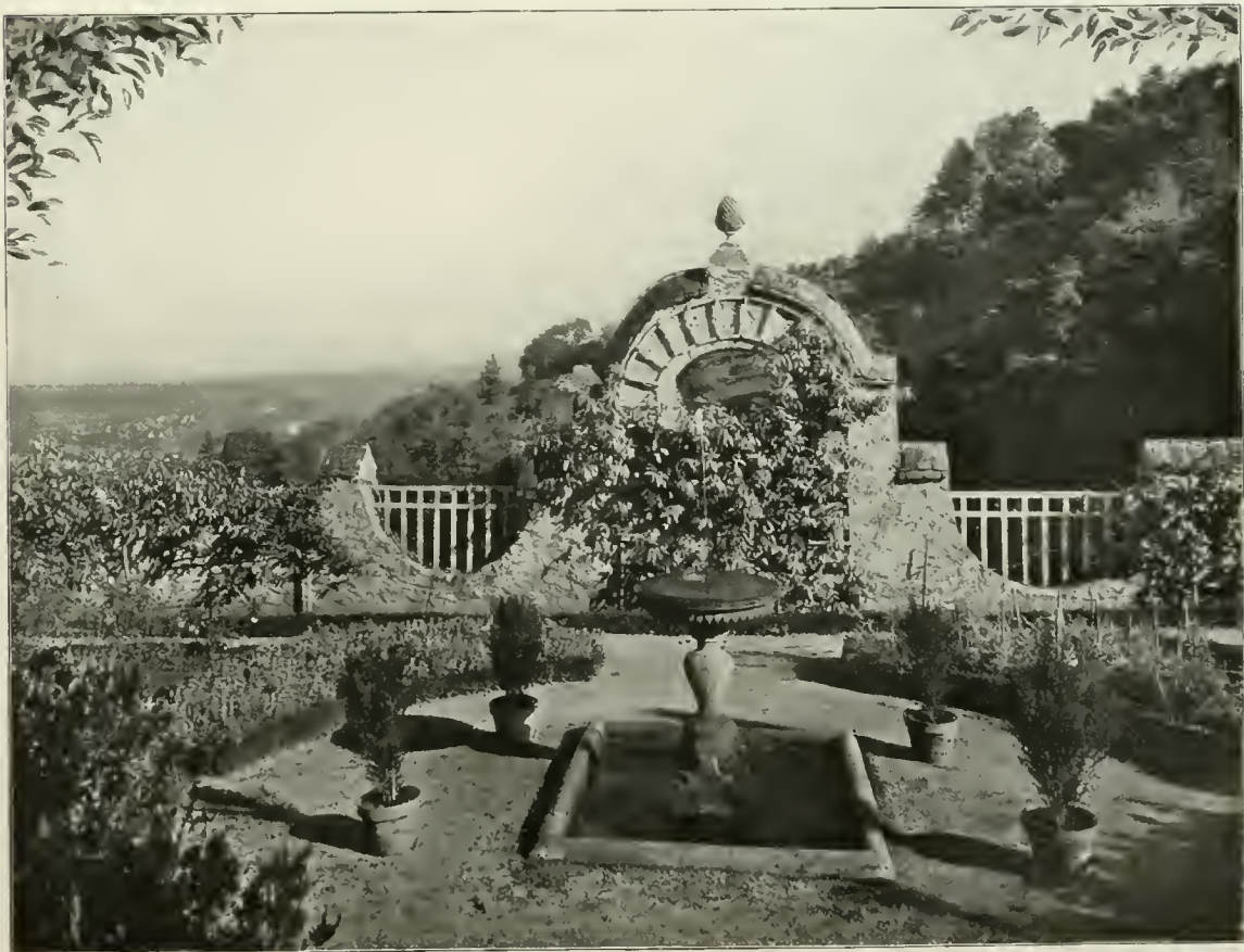
Landsitz des Freiherrn M. v. Heyl in Seeheim. Architekt Professor Fr. Schumacher, Hamburg.
