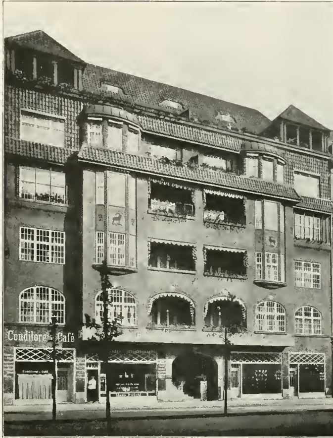
Haus mit Dachgarten: Innsbruckerstr. 40, Berlin Schöneberg. Architekt Paul Jonathan.
