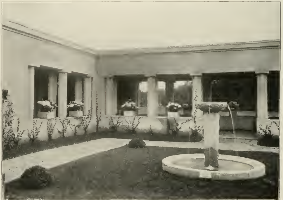
Friedhofs-Ausstellung Breslau: Der Säulenhof (Urnenhof) mit Durchblick nach dem Park. Phot. Heicke.
