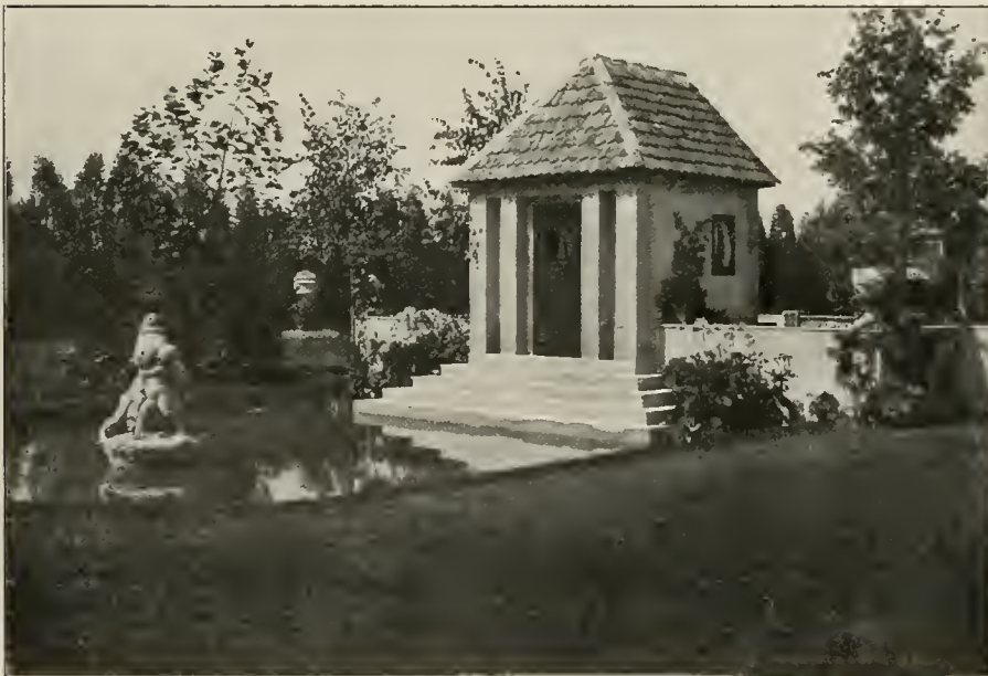
Abb. 6. Sondergarten von Otto Froebel's Erben, Zürich: Rückseite des Gartenhauses mit Wasserbecken.
