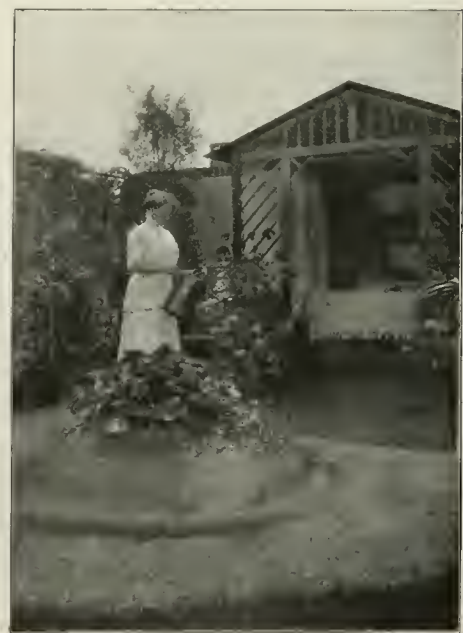
Dachgarten Schlüterstr. 40, Charlottenburg.
