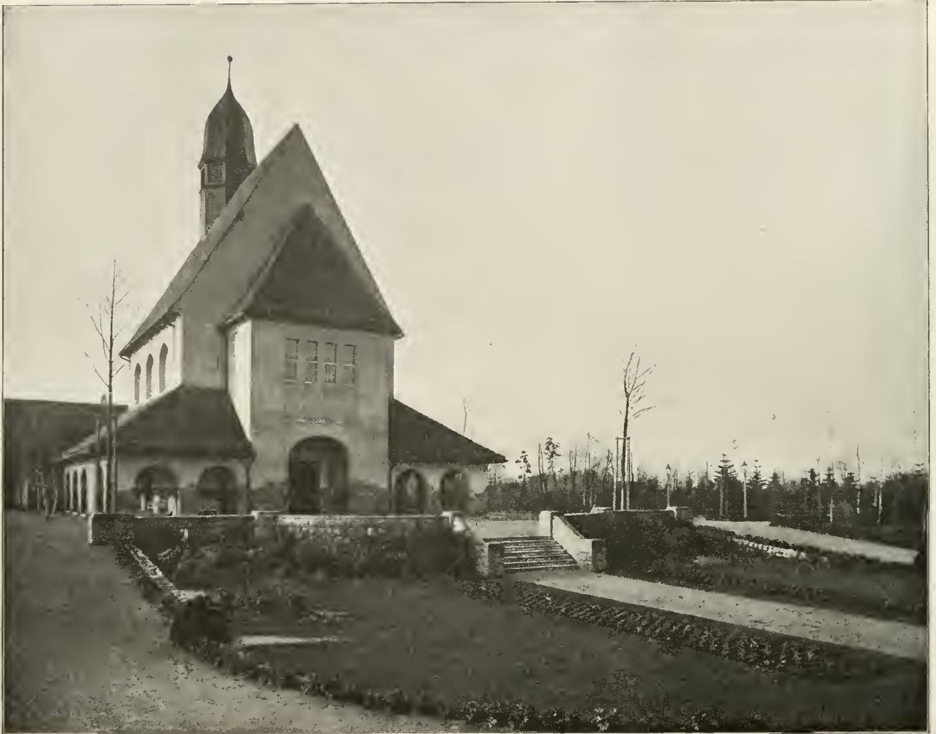
Einsegnungshalle des Friedhofs Rostock-Damerow.
