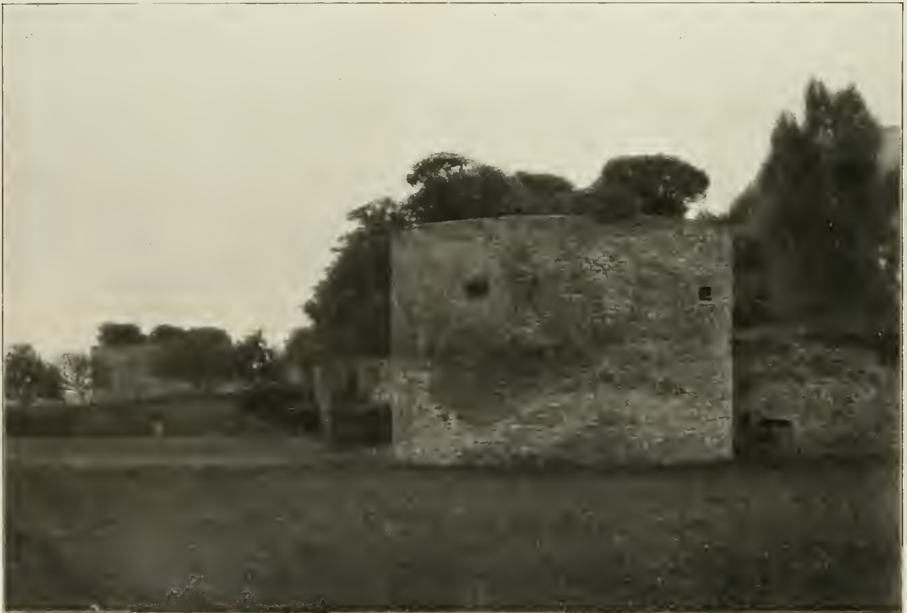
Bastionen der Burg in Babenhausen. Aufnahme von L. F. Fuchs, München.
