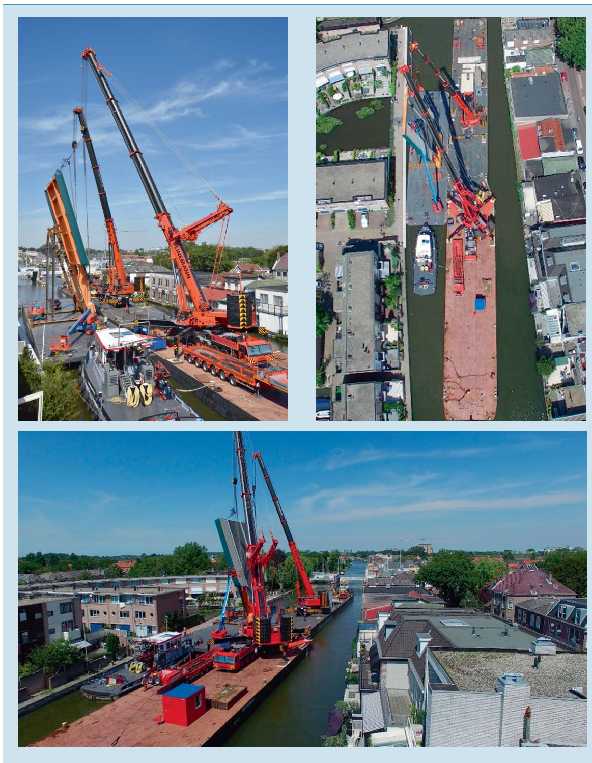
Figuur 43: Overzicht opstelling pontons, kranen en val. (Foto's: fotograaf kraanbedrijf en dronebeeld Dick van Smirren)
