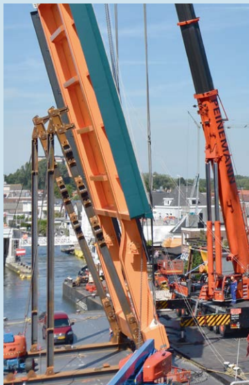
Figuur 45: Val aan bovenzijde los van schuinstelling, onderzijde op oplegging, tijdstip: ca. 15.30 uur. (Foto: fotograaf kraanbedrijf)
