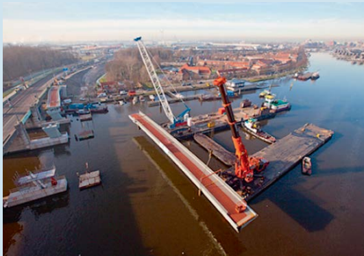
Figuur 24: Plaatsing fietsbrug Den Uylbrug Zaandam 2012. (Foto: website kraanbedrijf)
