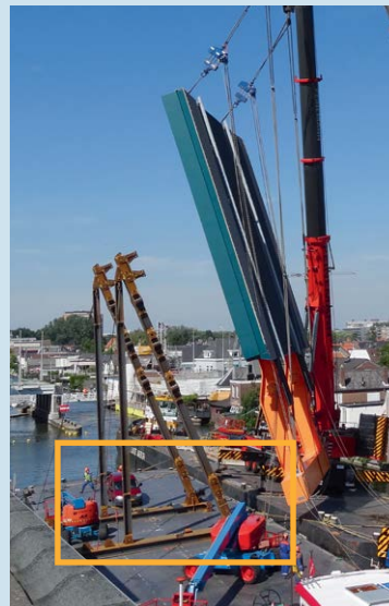
Figuur 47: Val is los, strop met kettingtakel liggen naast schuinstelling, tijdstip: ca. 16.05 uur. (Foto: getuige)
