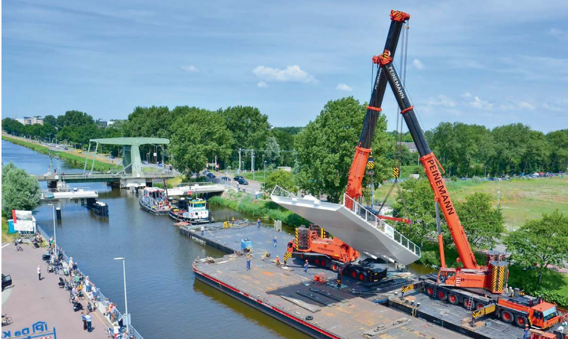
Figuur 13: Inhijzen brugdeel van de Victoriebrug in Alkmaar. (Foto: J. Stouthandel Fotografie)
