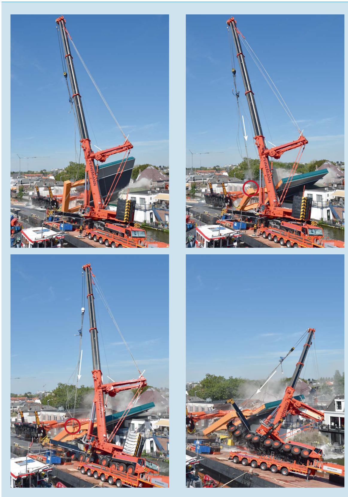
Figuur 52: Situatie na 60 - 65 seconden, moment dat brugdeel om lengte-as draait en, via het onderste hijs oog, de grote kraan meetrekt. (Foto's: fotograaf kraanbedrijf)
