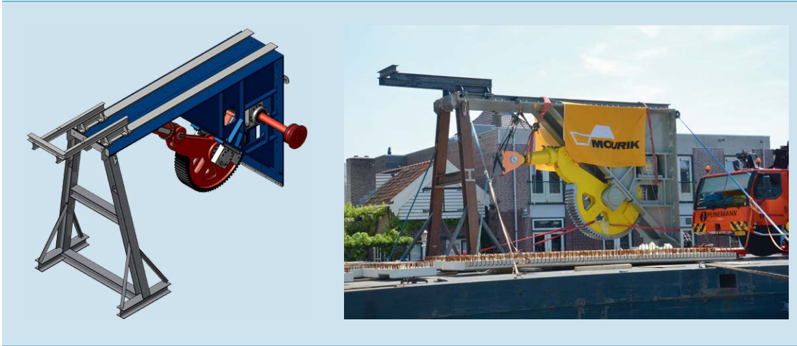
Figuur 7: Tekening frame met panamawiel en opstelling ervan op het smalle ponton. (Foto: Josh Walt)
