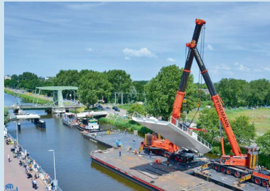
Figuur 25: Plaatsing fietsbrug Victoriebrug Alkmaar 2014. (Foto: J. Stouthandel Fotografie)
