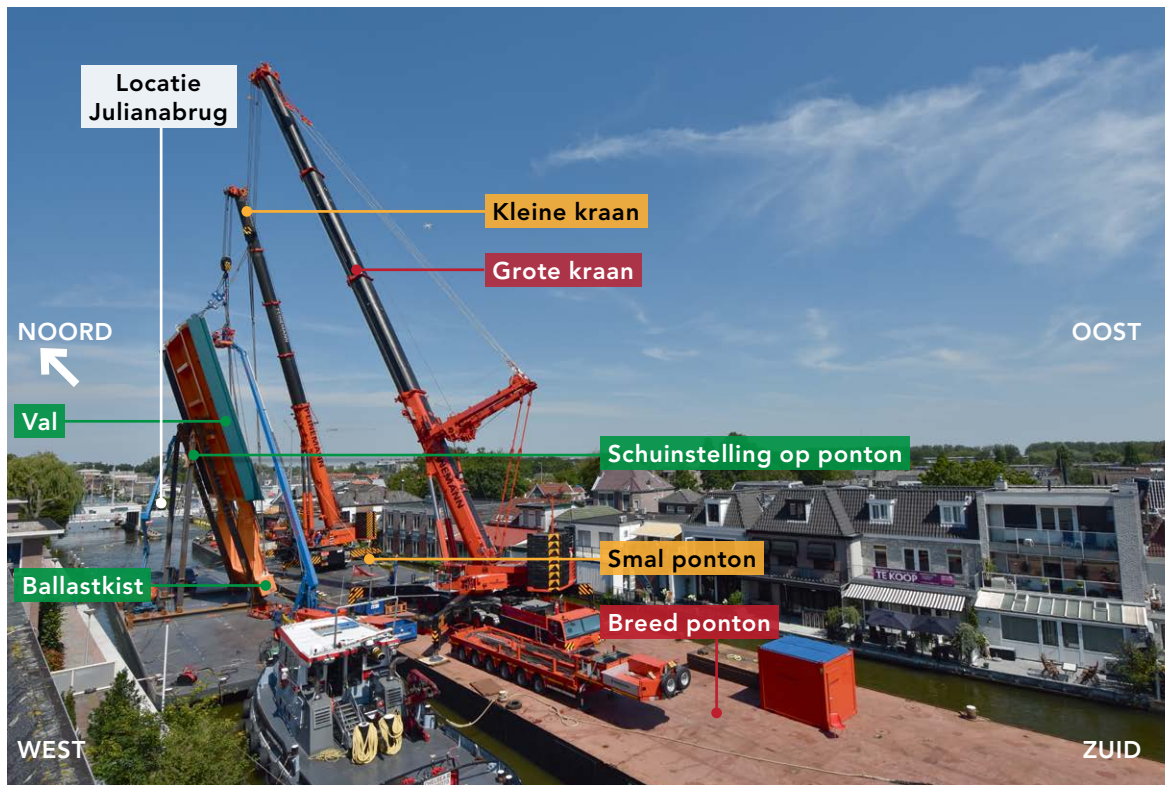
Figuur 1: Hijsofstelling bestaande uit pontons, kranen en brugdeel. (Foto: fotograaf kraanbedrijf)
