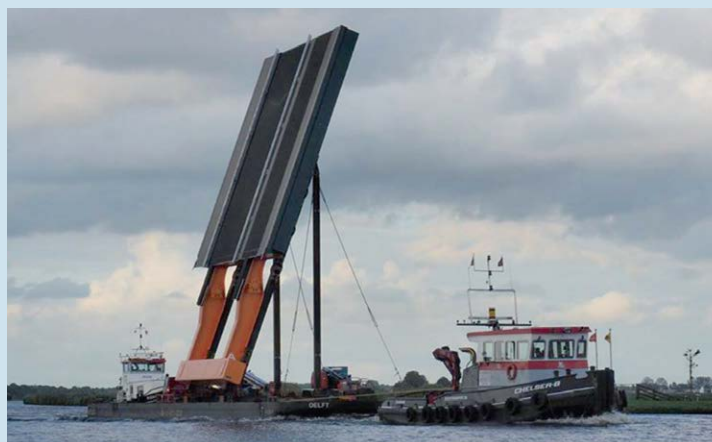
Figuur 27: Vervoer van het val op ponton Attack met sleepboot. (Foto: Anne de Boer, www.alphens.nl )
