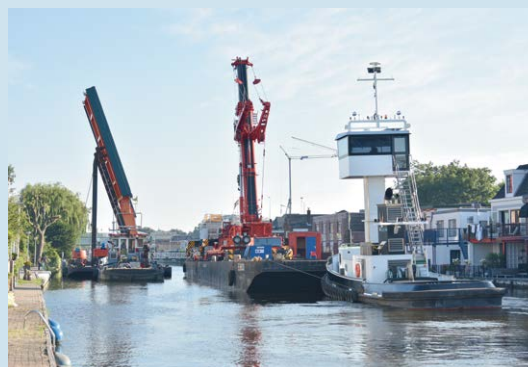
Figuur 30: Aankomst ponton E1601 met de nog op te bouwen grote kraan in Alphen.(Foto: kraanbedrijf)
