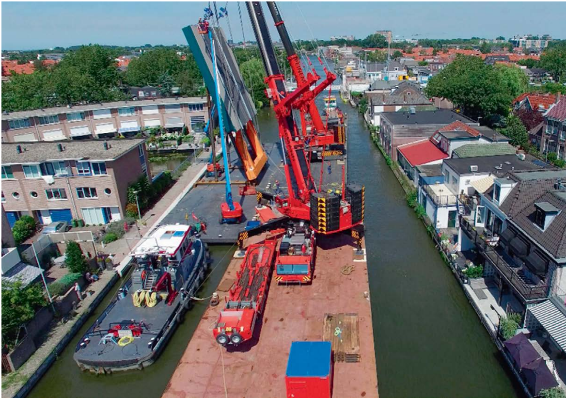
Figuur 16: Hijsopstelling op het water bestaande uit drie pontons, een schuinstelling en twee mobiele kranen. (Bron: dronebeelden Dick van Smirren)
