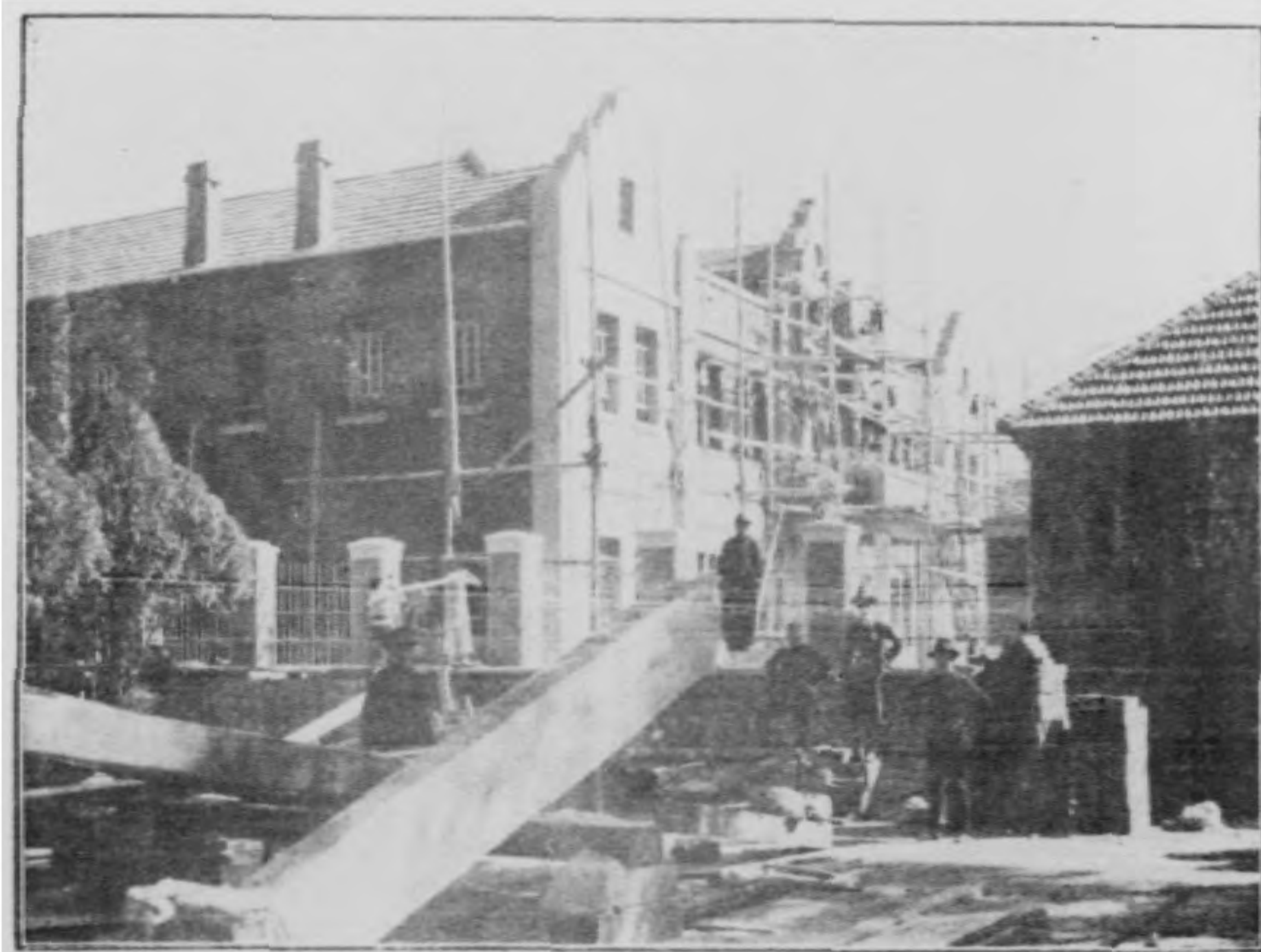
新建本局辦公大樓作水刷石工程情形
