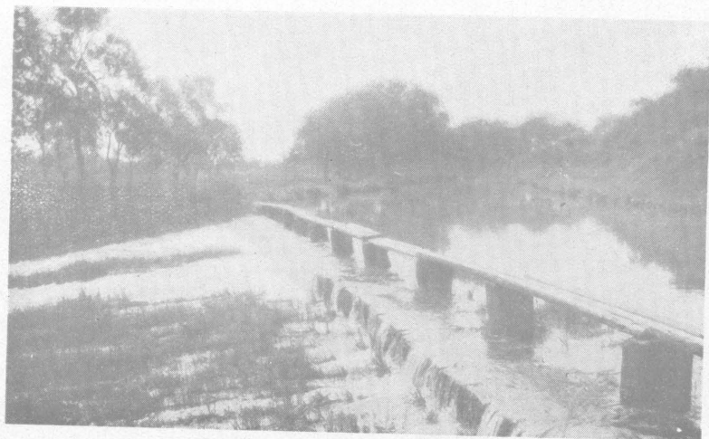
圖十五 靈渠瀉水天平
