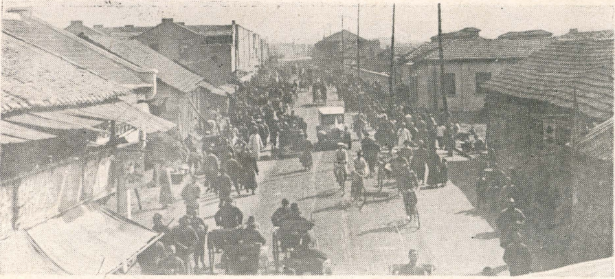
翻修雙洞門馬路竣工狀況
