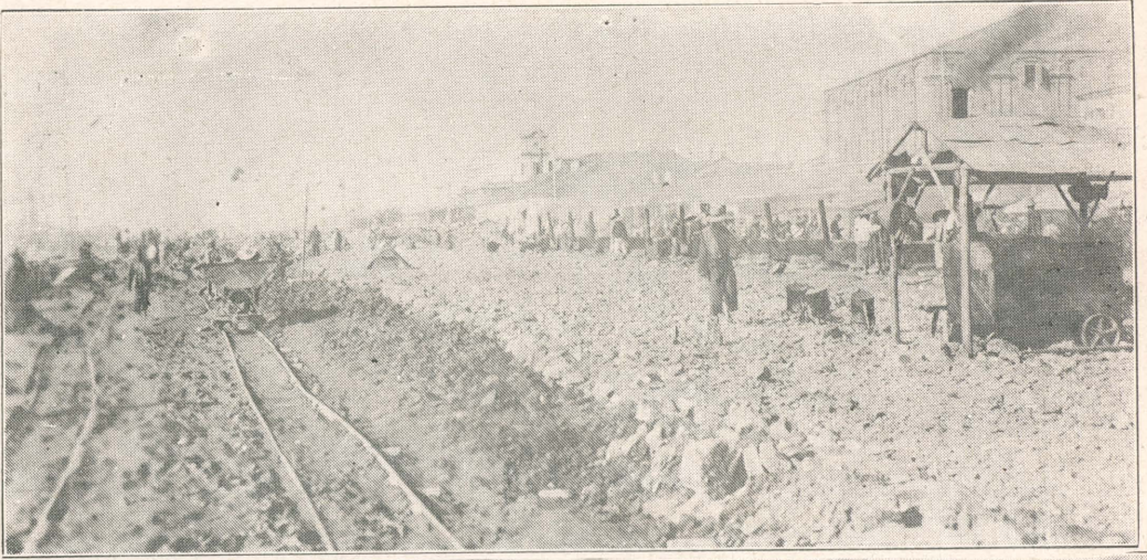
鋪修沿江馬路路面工程攝影之二
