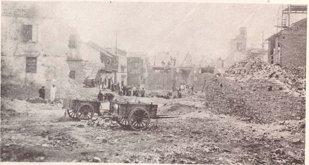
民權路折卸後狀況
