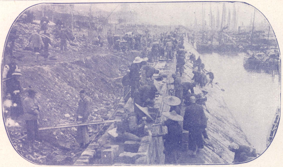
建築沿江堤岸攝影之二
