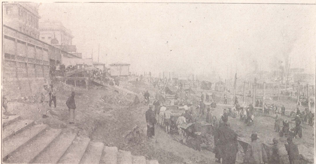
建築沿江馬路運土填築堤岸情形
