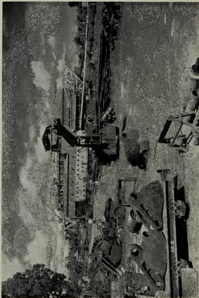
Afb. 2. Eindmontage van de tinbaggemolen „Kalmoa” (Billiton) — Foto Panorama.
