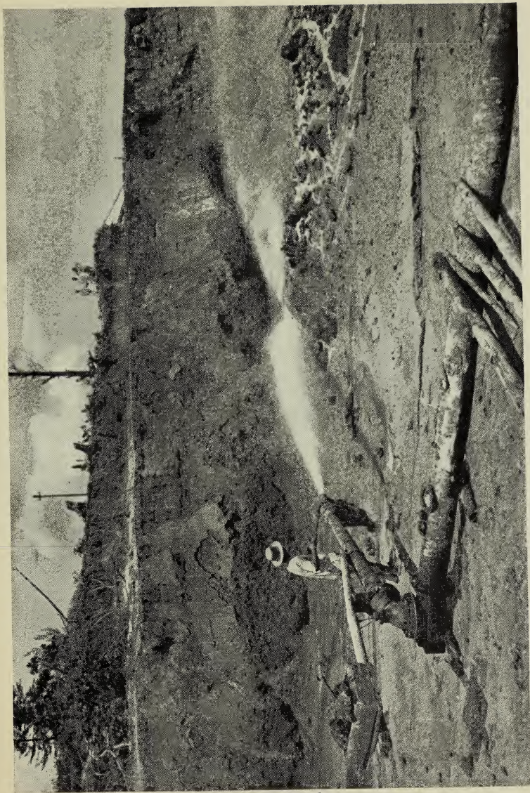
Afb. 1. Losspuiten van de grond door middel van een z.g. „Monitor”, onder een druk van 7—10 atm. (Billiton) — Foto Panorama.
