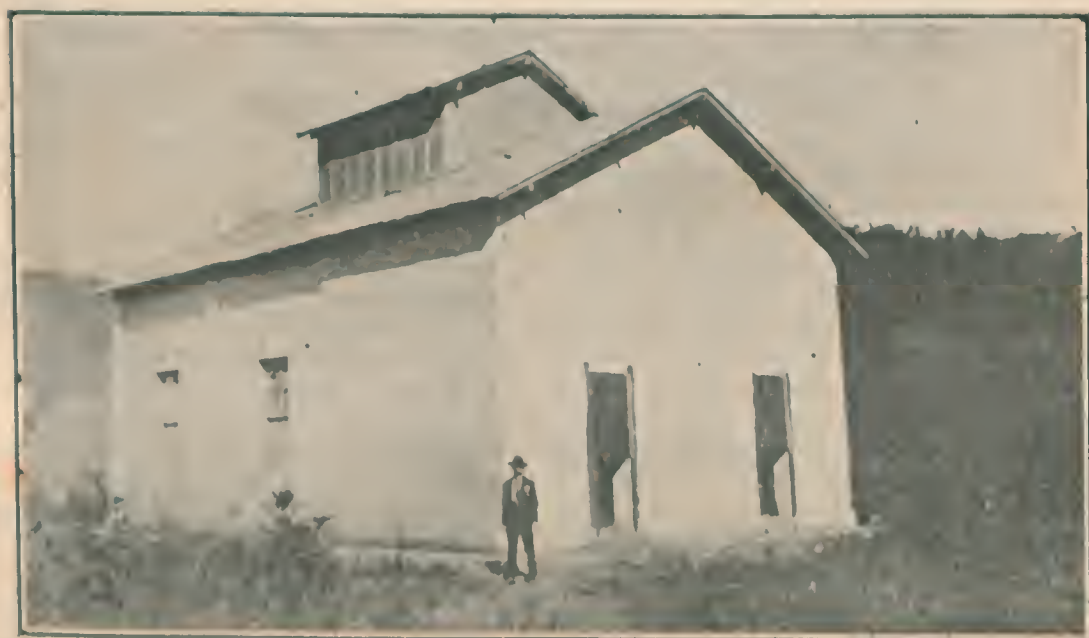
Expurgador construido pelo Governo Federal para purificação de sementes de algodão destinadas a distribuição aos fazendeiros. O expurgador foi construido em 1921, em Belo Horizonte.
