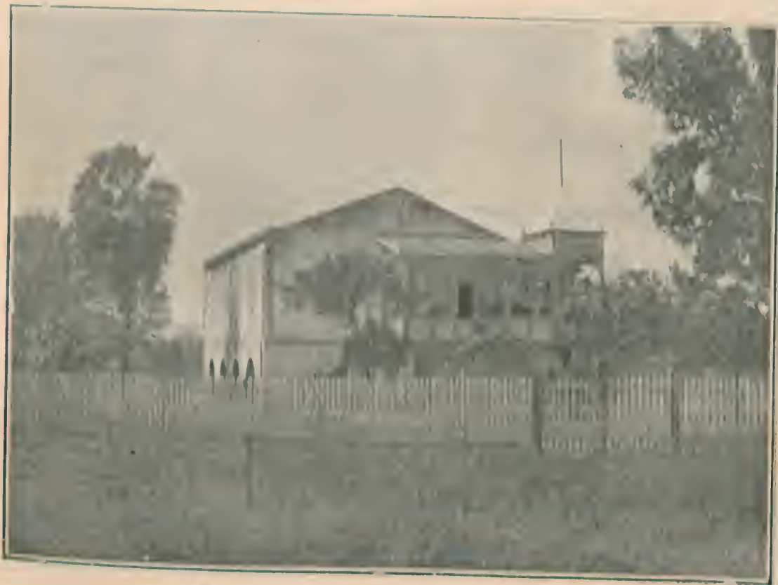
Fabrica "VILLA NOVA" - Residência do Gerente
