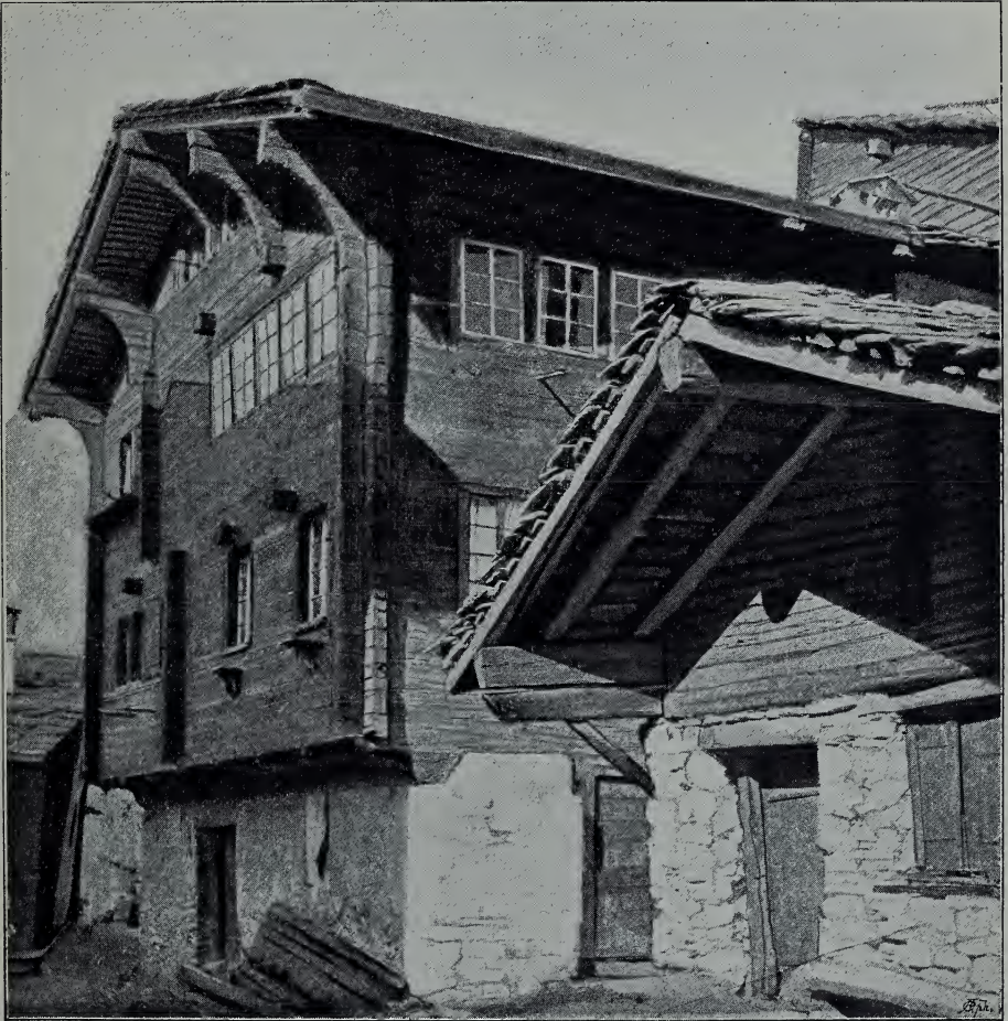
Fig. 116. Häuserpartie aus Stalden.
