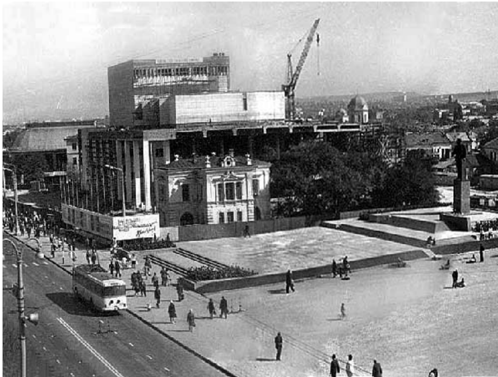
Зведення сучасної будівлі Кримського академічного українського музичного театру. Рідкісний знімок: театр побудовано, а СЕС, що була на його місці, ще не знесено
