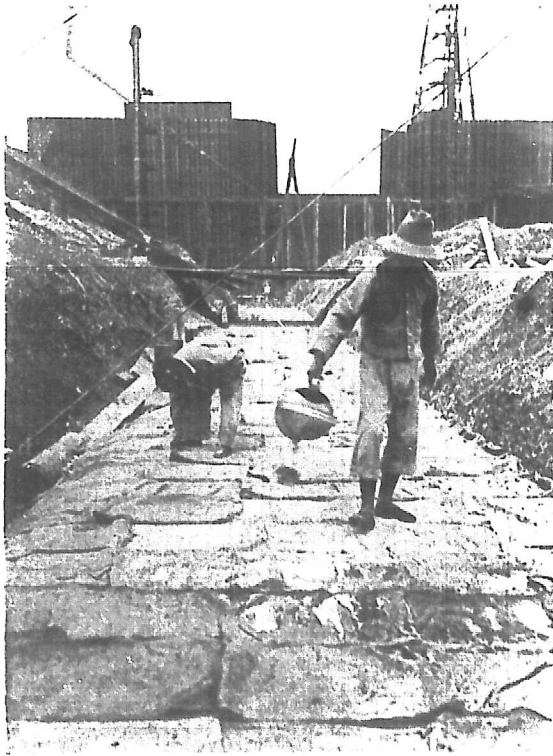
第五十五圖 混凝土之蓋護及澆水工作
