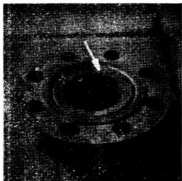
图 8 重油炉进口法兰腐蚀情况
