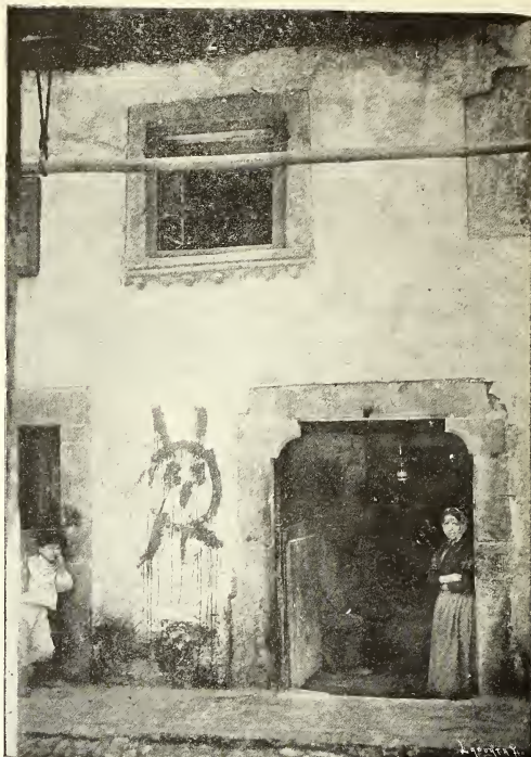
Casa núm. 29 de la calle del Rosario.
