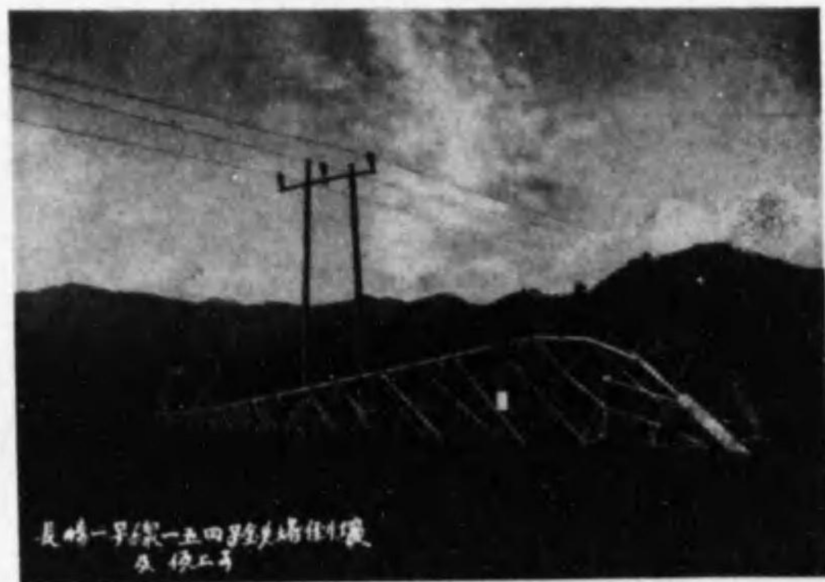
第26圖 昭和5年九州區域水害狀況 鐵塔の倒壊
