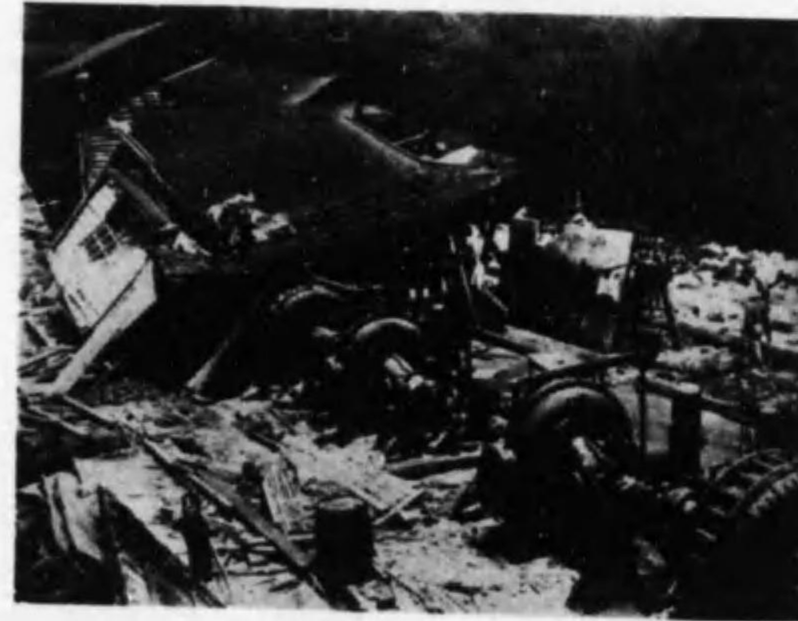
第28圖 昭和5年九州區域水害狀況 川上川發電所の倒壊
