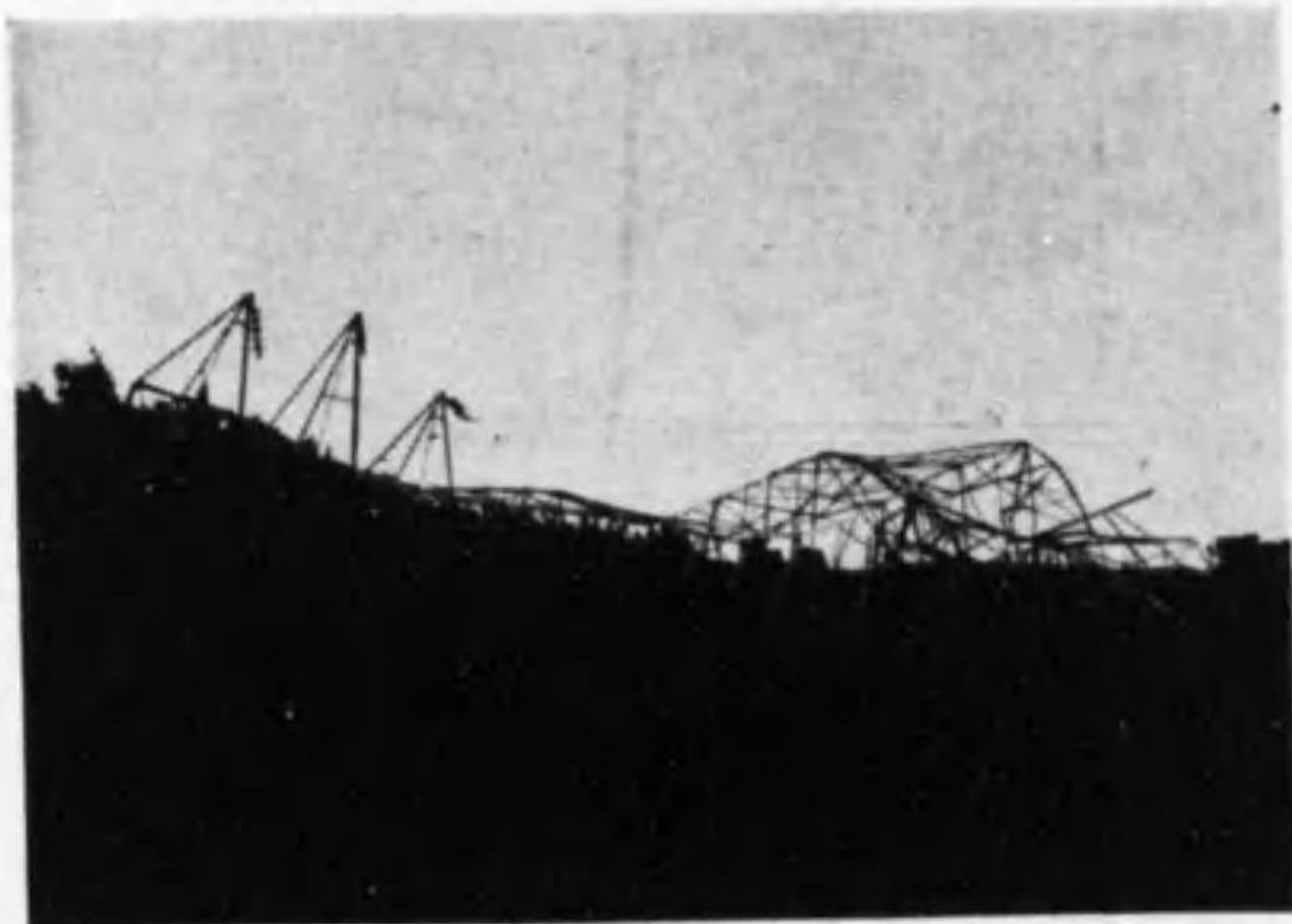
第25圖 昭和9年關西區域風水害狀況 道徳新富田 30kV 木曾川横斷ヶ所鐵塔の倒壊
