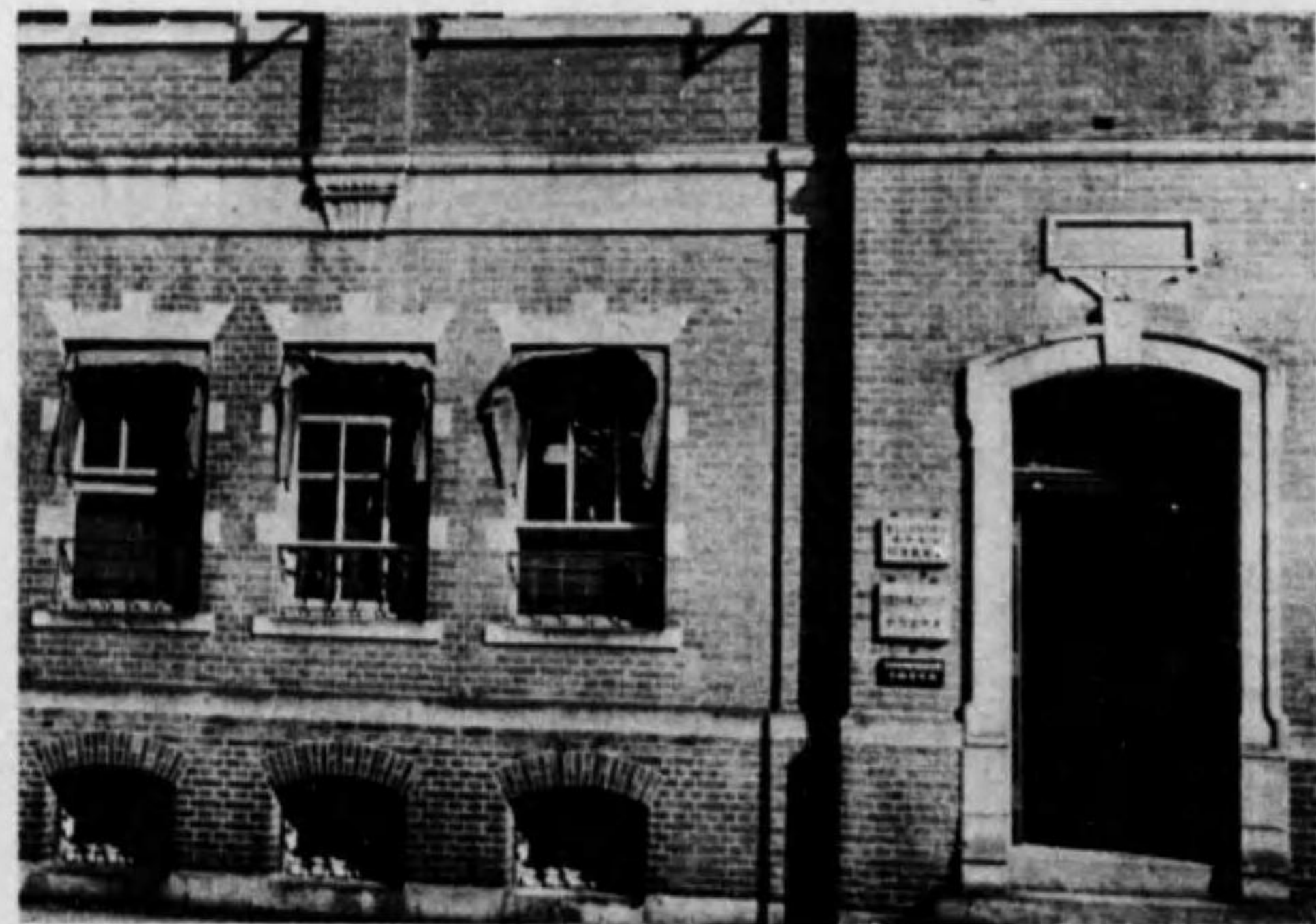
舊東京支店 (丸ノ内十二號館) 建物 の一部
