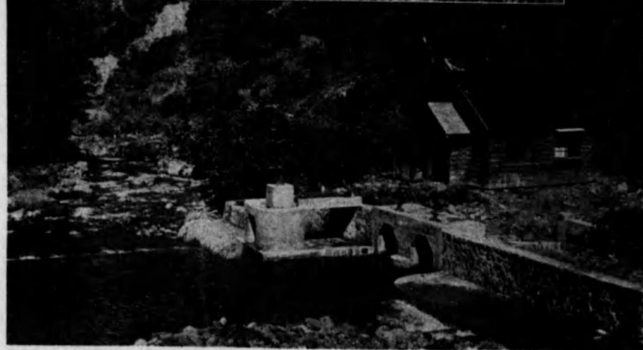
小出發電所白雲川取水口
