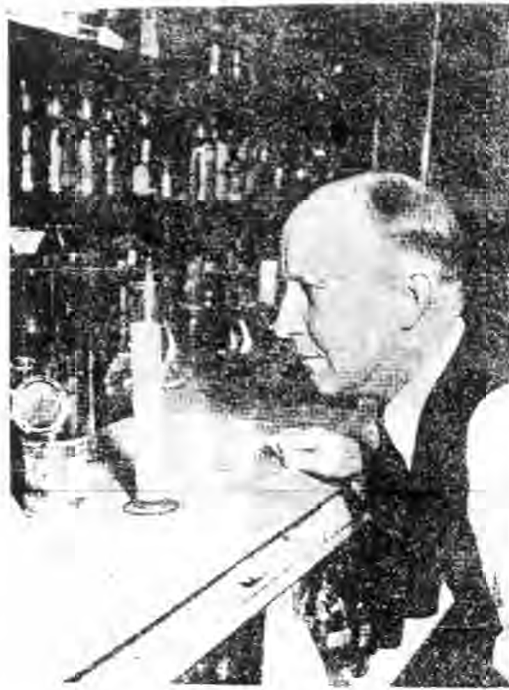
菓汁中如含有大量凝固體則殊難保藏 圖示馬氏用浮秤以驗罐頭菓汁之狀
