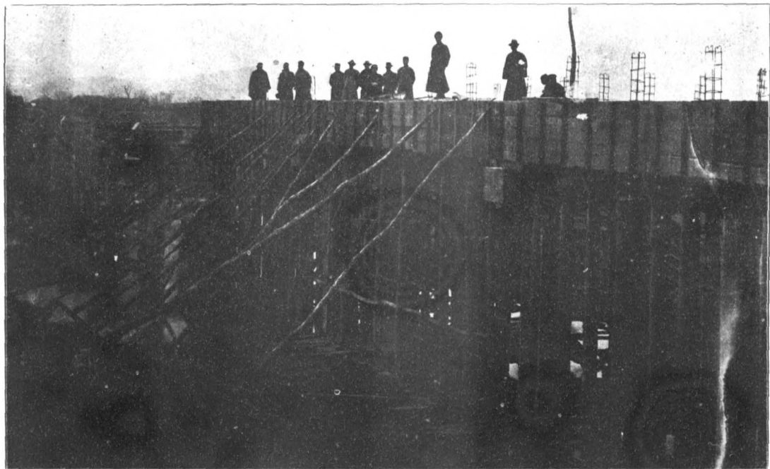
影攝時工施橋土凝混筋鋼河竿竹路潢信視巡師程工李工監總漢同率長處羅
