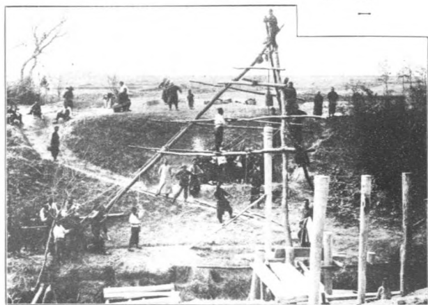
← 本處木架橋施工之三 (商葉路西沙河橋)
