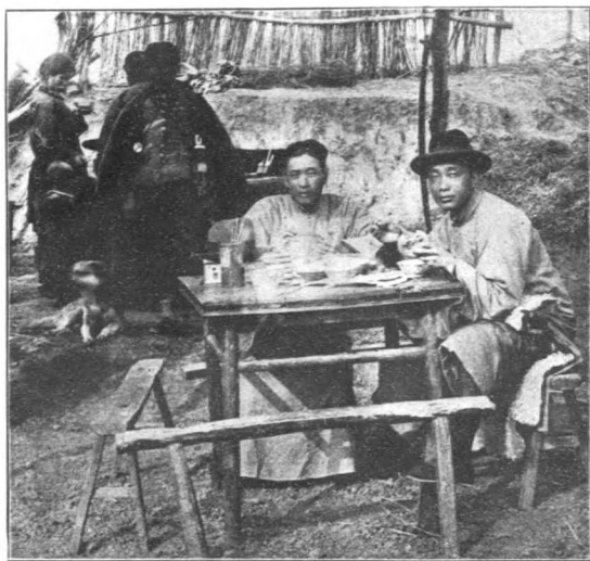
本處王前處長橫小道上督工生活之一班 (上圖右座者爲王前處長上座者爲工程師 兼橋樑施工事務所主任李之銘)
