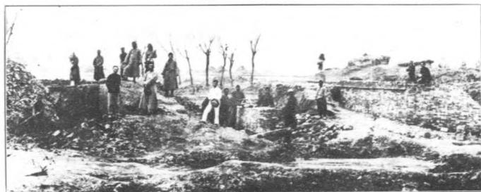
(橋坊槽路小潢) 三之工施橋面木墩磚處本
