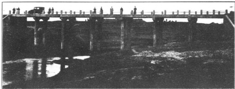
影攝成完橋土凝混筋鋼河潢小路潢信 (孔七共尺公七十四長全)
