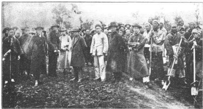
本處普通通路基施工情形之二(潢商路)
