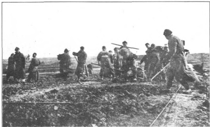
本處普通通路基施工情形之一 (張廳長視察潢小路時攝贈)
