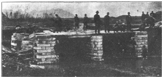
（橋家趙路漢信）二之工施橋面木墩石處本
