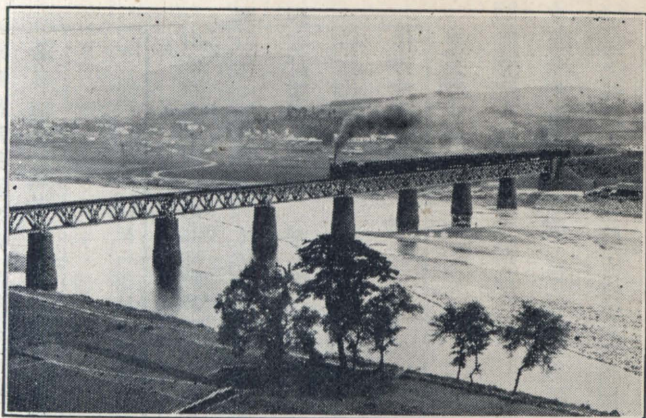
安 奉 線 橋 頭 鐵 橋
