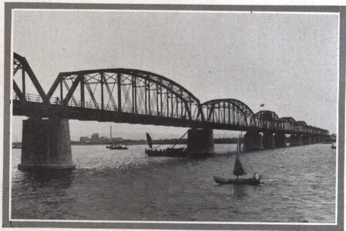
鴨 綠 江 大 鐵 橋
