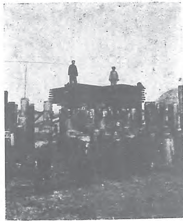
劉澗船開基樁重載試驗情形
