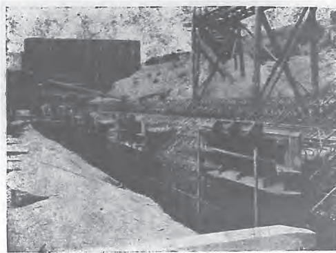
邵伯閘輸水道鋼筋結構
