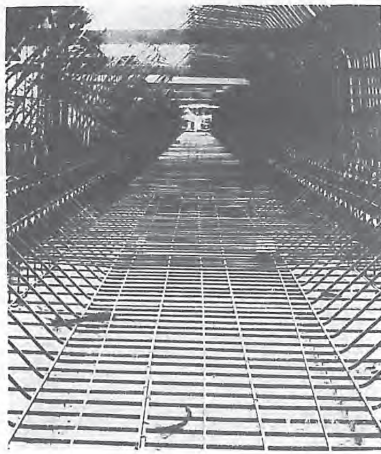
邵伯閘輸水道鋼筋結構
