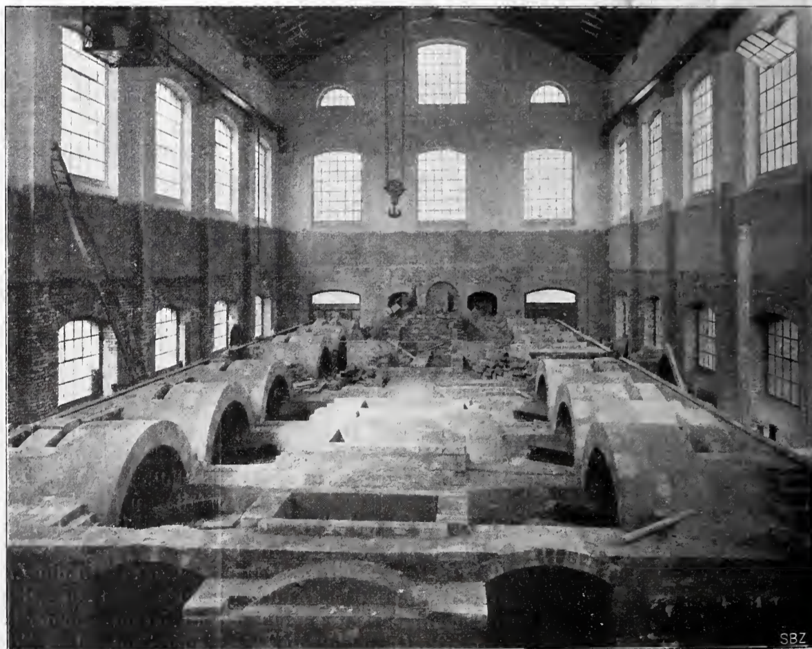
Abb. 11. Ofen-Zellen im Bau. II. Periode.
