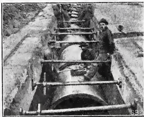
Abb. 18. Anwendung ausziehbarer Spiessen.
