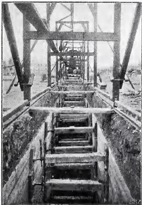
Abb. 16. Anwendung ausziehbarer Spriessen.
