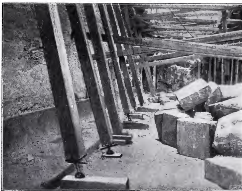
Abb. 17. Anwendung ausziehbarer Spriessen.
