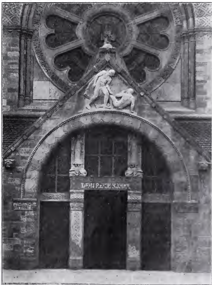
Abb. 2. Ansicht des Hauptportals der Pauluskirche in Basel.
