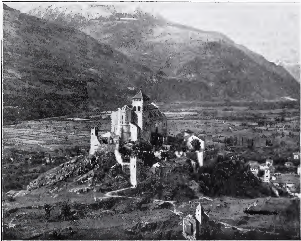
Ansicht des Schlosses von Nordost von der Burg Tourbillon aus. Nach einer Tafel der «Kunstdenkmäler der Schweiz». Neue Folge, Heft IV.
