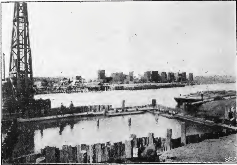
Abb. 8 und 9. Spundwand der Baugrube für eine Hub- und Rollbrücke am Chicagoflusse.
