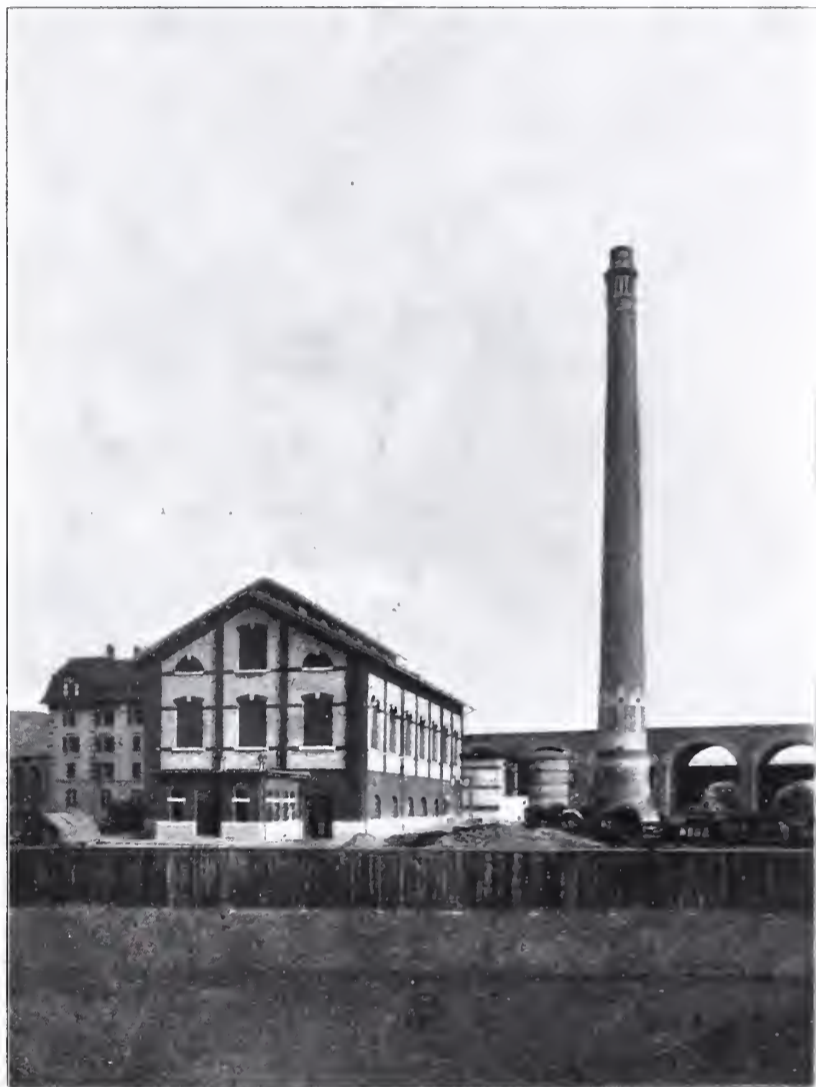
Abb. 1. Ansicht von Westen.
