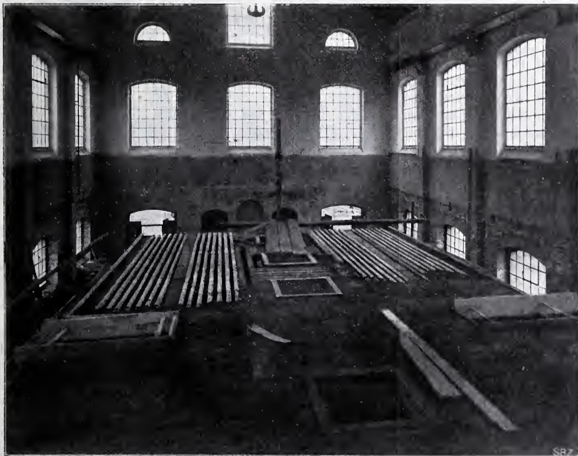
Abb. 13. Ofen-Zellen im Bau. IV. Periode.
