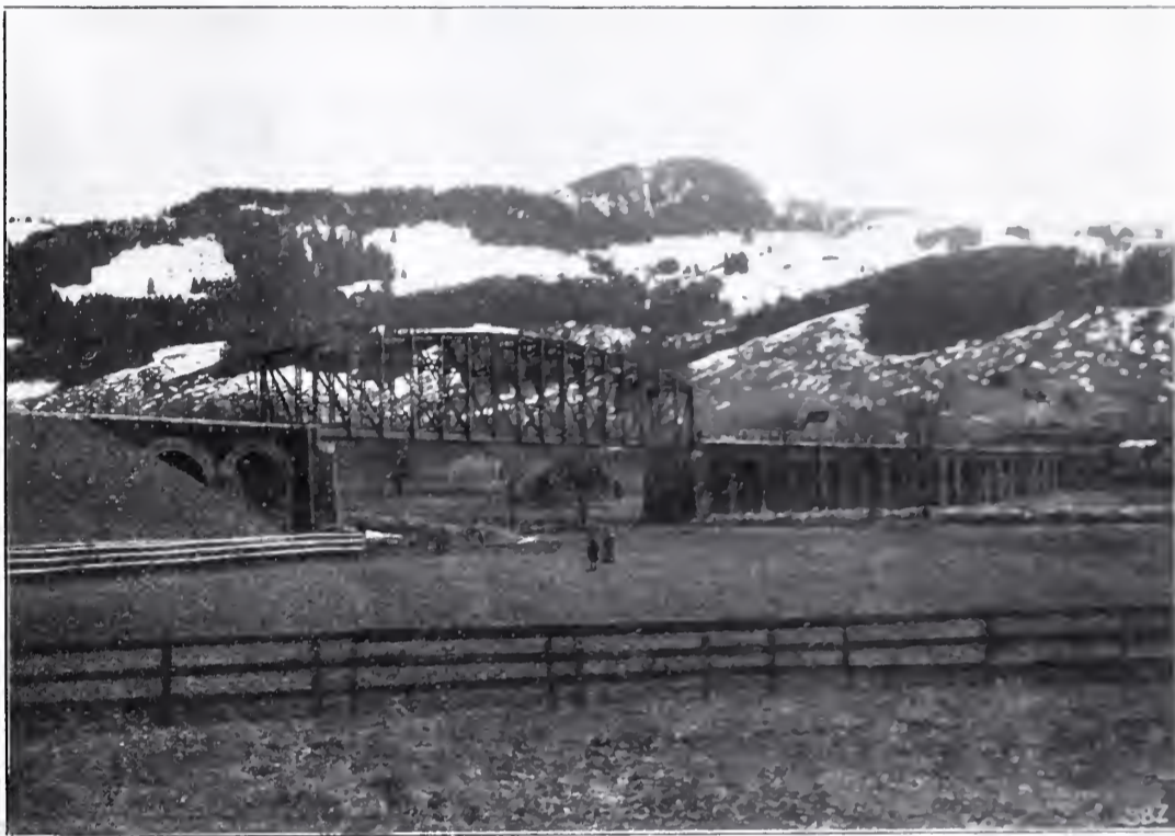
Abb. 1. Viadukt bei Appenzell. — Ansicht von Norden.
