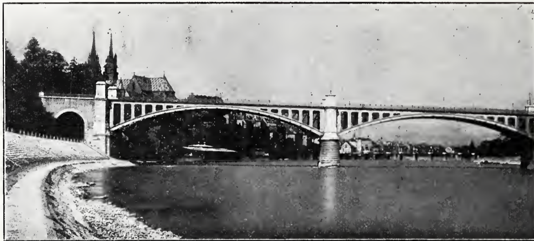
Ansicht der Wettsteinbrücke an der Grossbasler-Seite stromabwärts.
