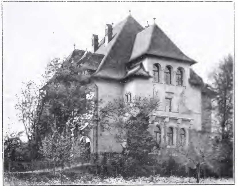
Abb. 2. Ansicht der Villa Sonnenberg von Norden.
