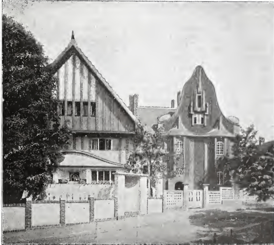
Abb. 5. Giebel des Eckhauses und des grauen Hauses der Dreihäusergruppe. Von Architekt Prof. J. Olbrich in Darmstadt.
