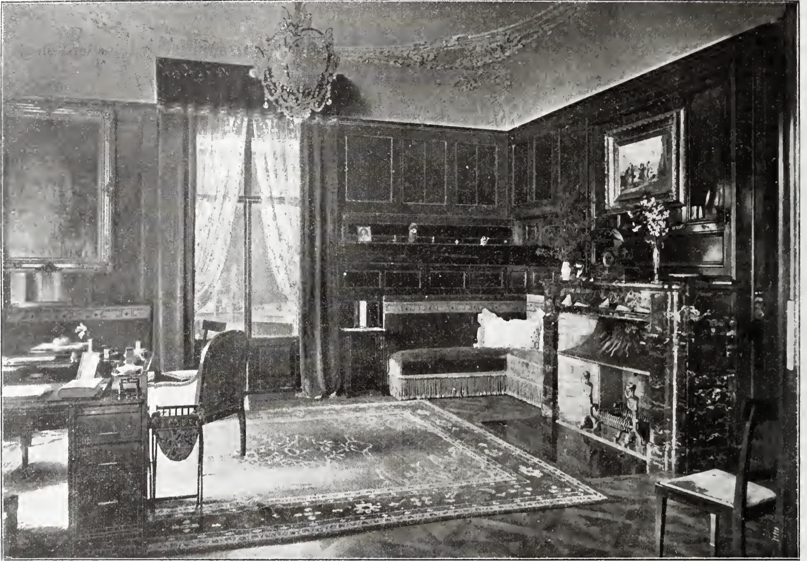
Abb. 8. Das Wohnzimmer im Erdgeschoss der Villa.
