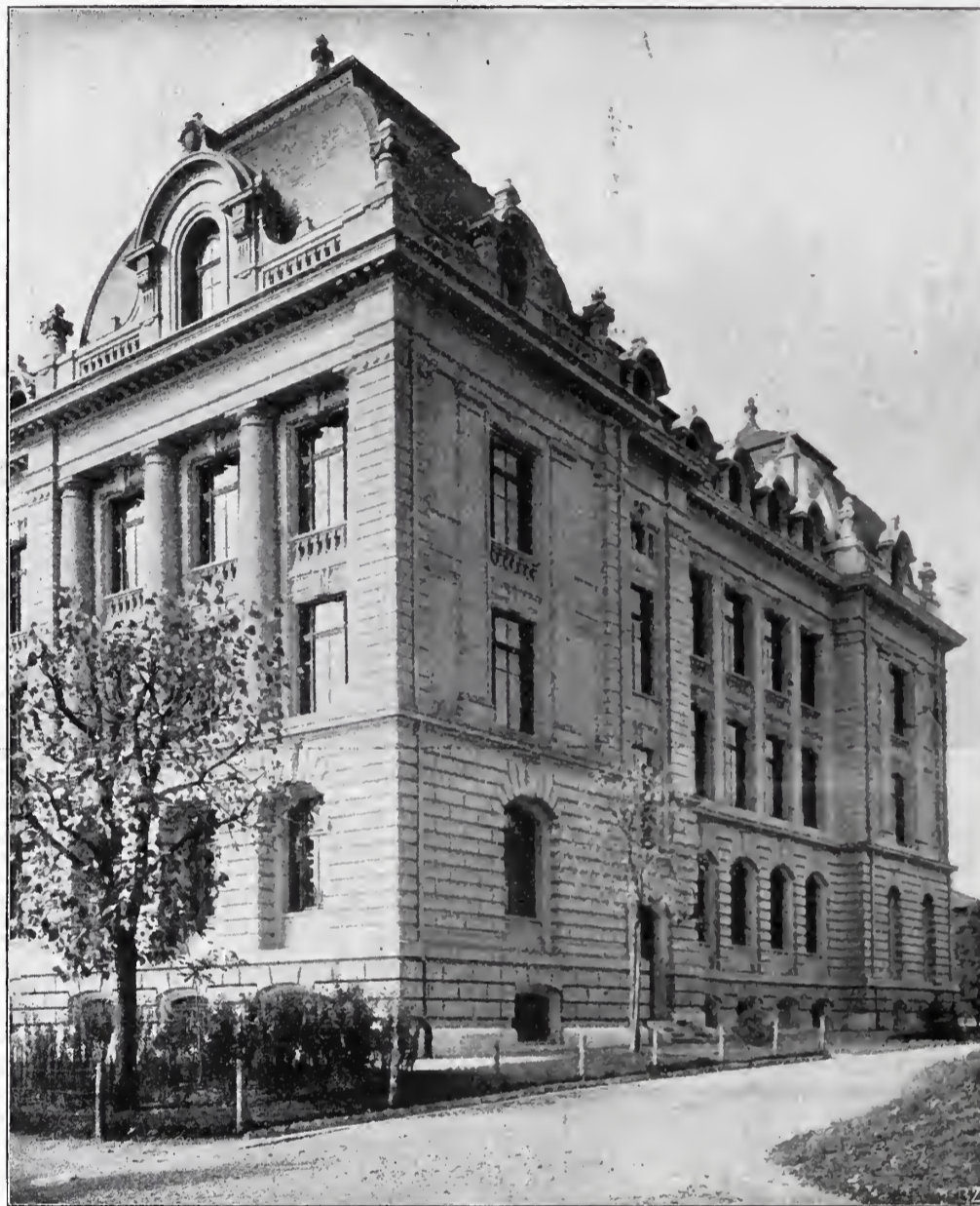
Abb. 12. Ansicht der östlichen Seitenfassade des Gebäudes.
