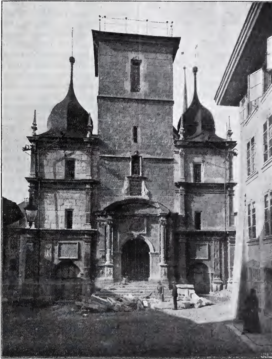
Abb. 1. Die alte Ostfassade des Rathauses zu Solothurn. Erbaut 1623—1626, 1704 und 1711 nach den Rissen von Baumeister Gregorius Bienkher .
