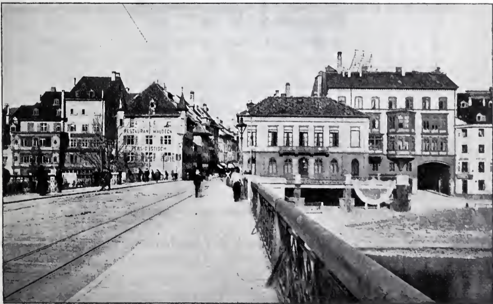
Ansicht des bestehenden Hauses der Drei E. Gesellschaften, von der alten Brücke.
