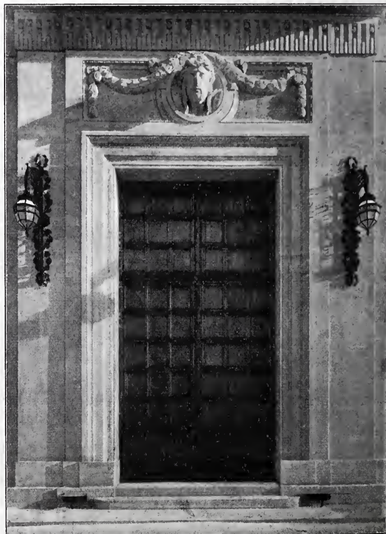
Abb. 6. Ansicht des Hauptportals.
