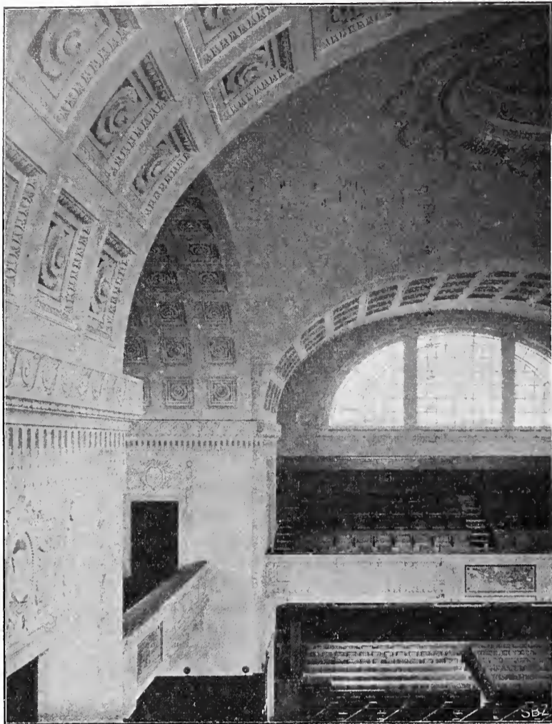
Abb. 5. Blick auf die Emporen.
