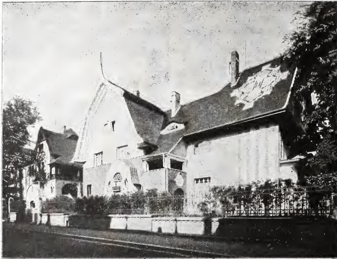
Abb. 4. Das blaue Haus und Seitenansicht des Eckhauses der Dreihäusergruppe. Von Architekt Prof. J. Olbrich in Darmstadt.
