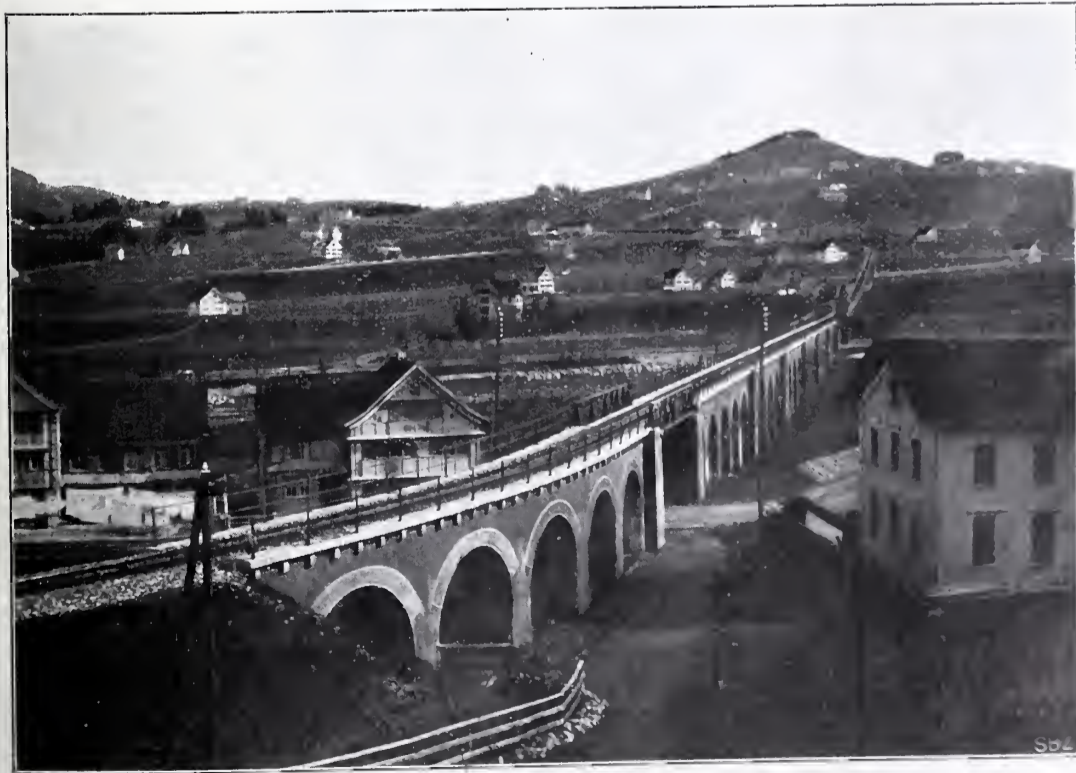
Abb. 2. Viadukt bei Appenzell. — Ansicht von Süden.
