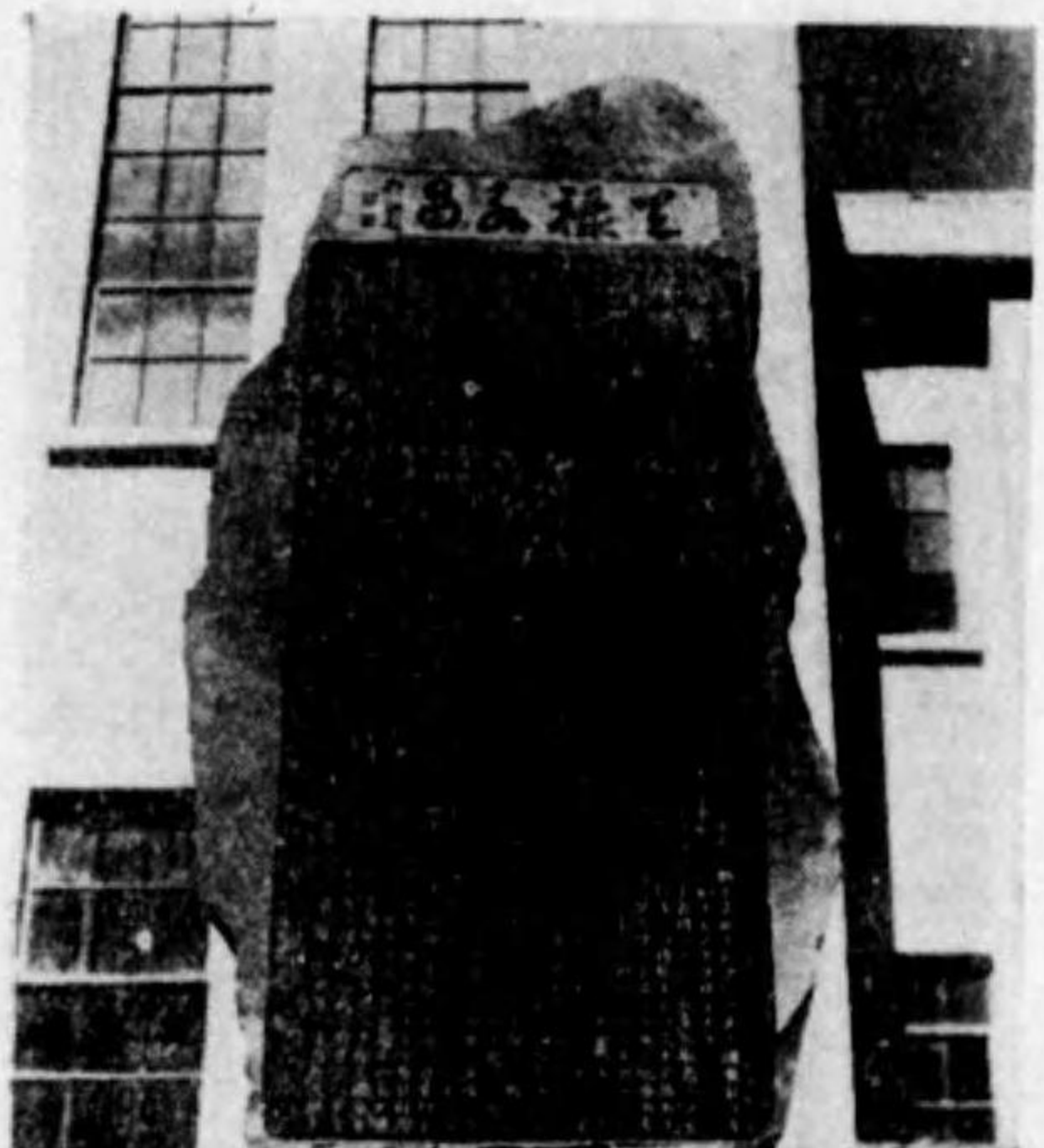
第三發電所竣功碑
