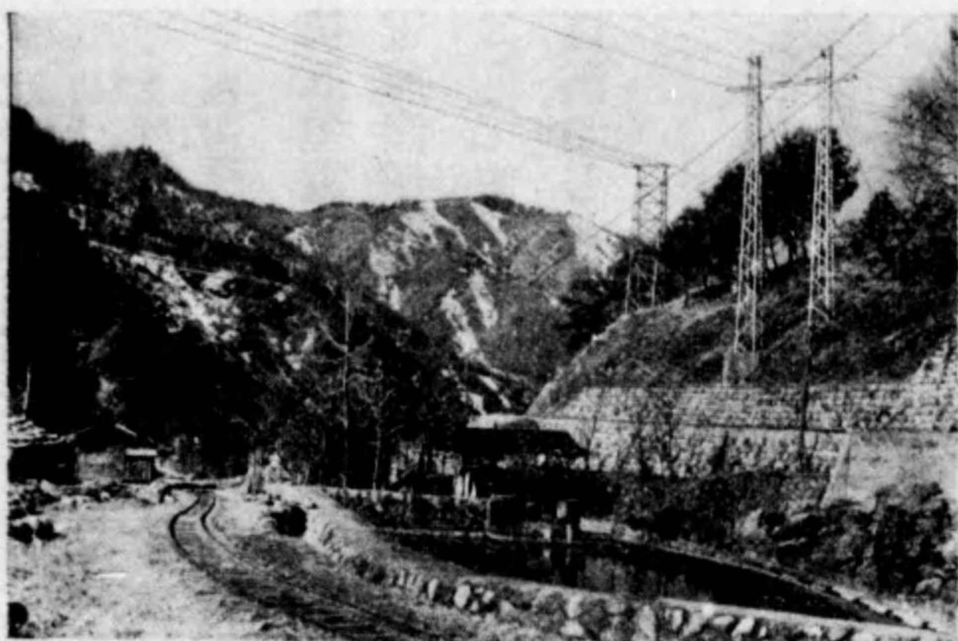
第一水力沈砂池、第一第三送電線、第二第一送電線
