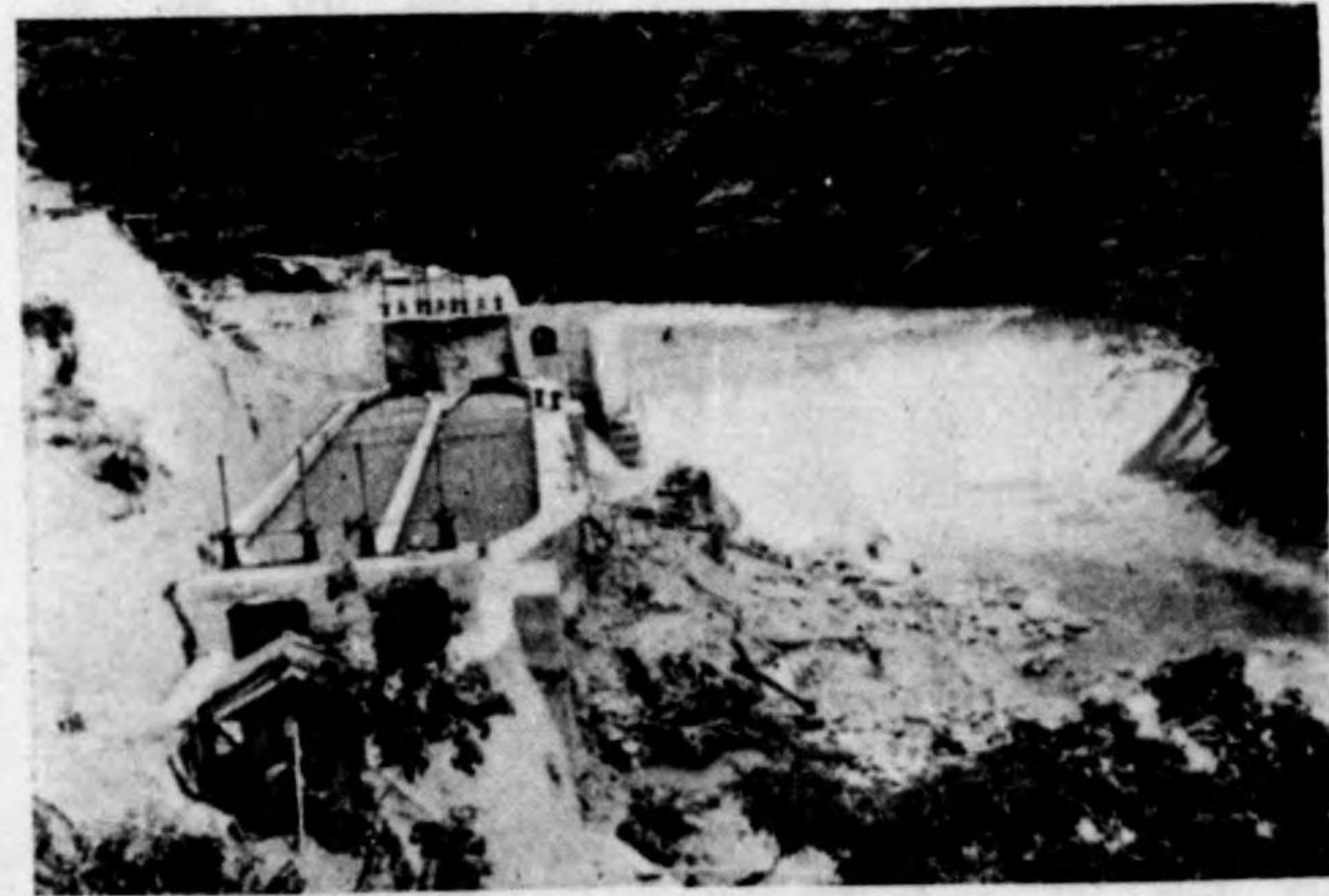
第三水力堰及沈砂池ノ全景
