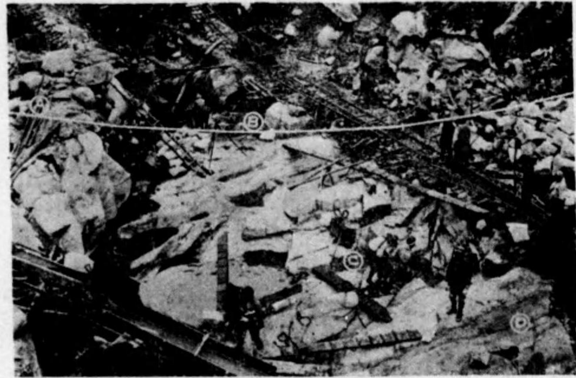
第三水力工事ノ堰敷及取水口前岩盤
