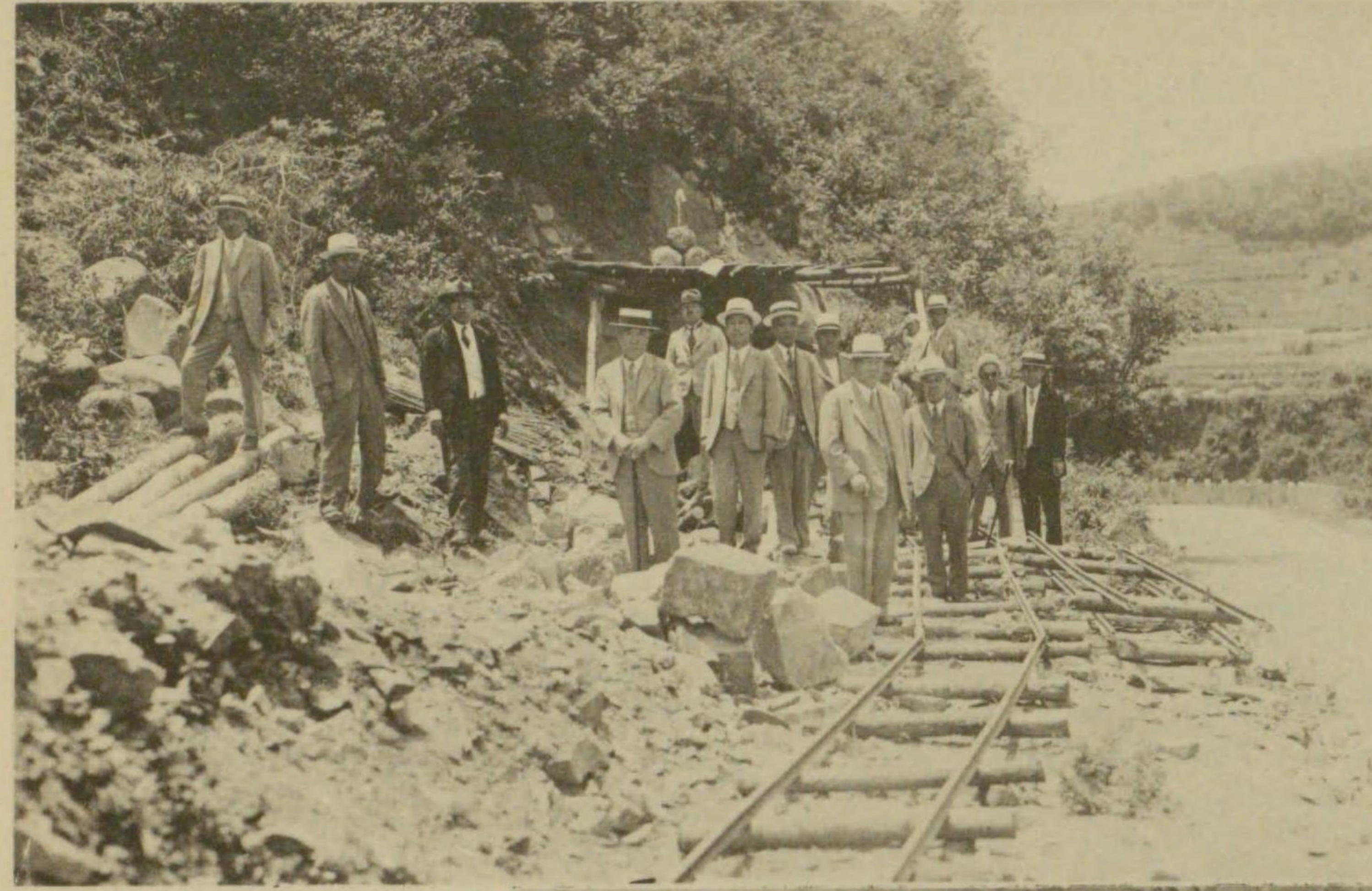
片山隧道擴張作業
