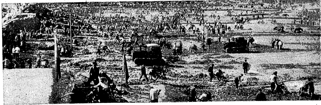
图为澧县澧阳平原园田化建设施工工地一角。
