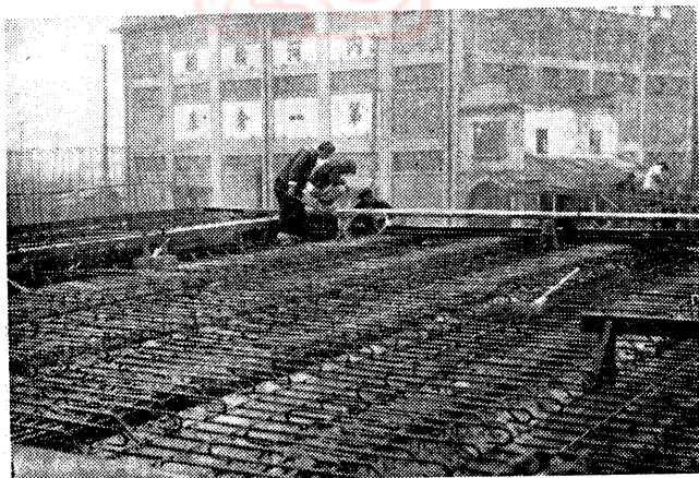
橋面鋪設鋼筋
