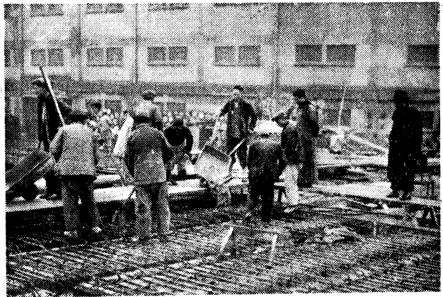
橋面澆橋水情形
