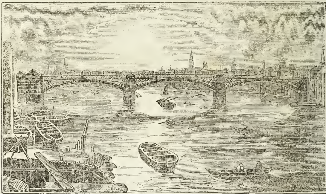
(Ponte in ferro, detto di Southwark, sul Tamigi, a Londra.)
