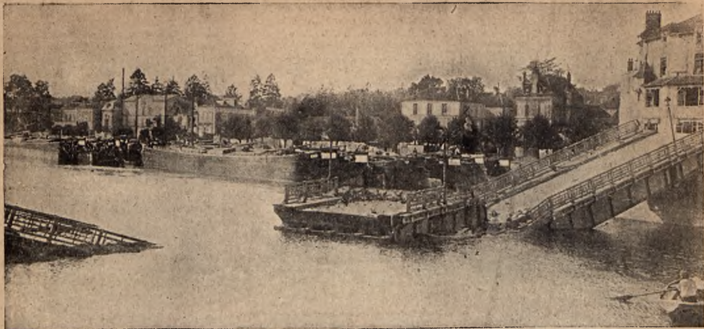
Мостъ на Марнѣ. въ Ланви. разрушенный французами, чтобы лишить германцевъ возможности переправить свои войска на другой берегъ.
