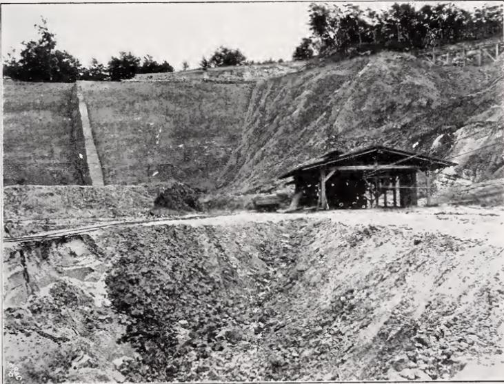
Fig. 2. Hintere Grubenwand: NO-SW. Septarienton mit starken Biegungen, durch die eingelagerten Septarien gekennzeichnet. Rechts beim Schuppen zwischen dem Septarienton und dem geschichteten Diluvialsande über der Grubensohle eingeklemmte Scholle von miocänen Braunkohlentonen und -sanden; links in der Grubensohle geschichteter Diluvialsand unter Septarienton.
