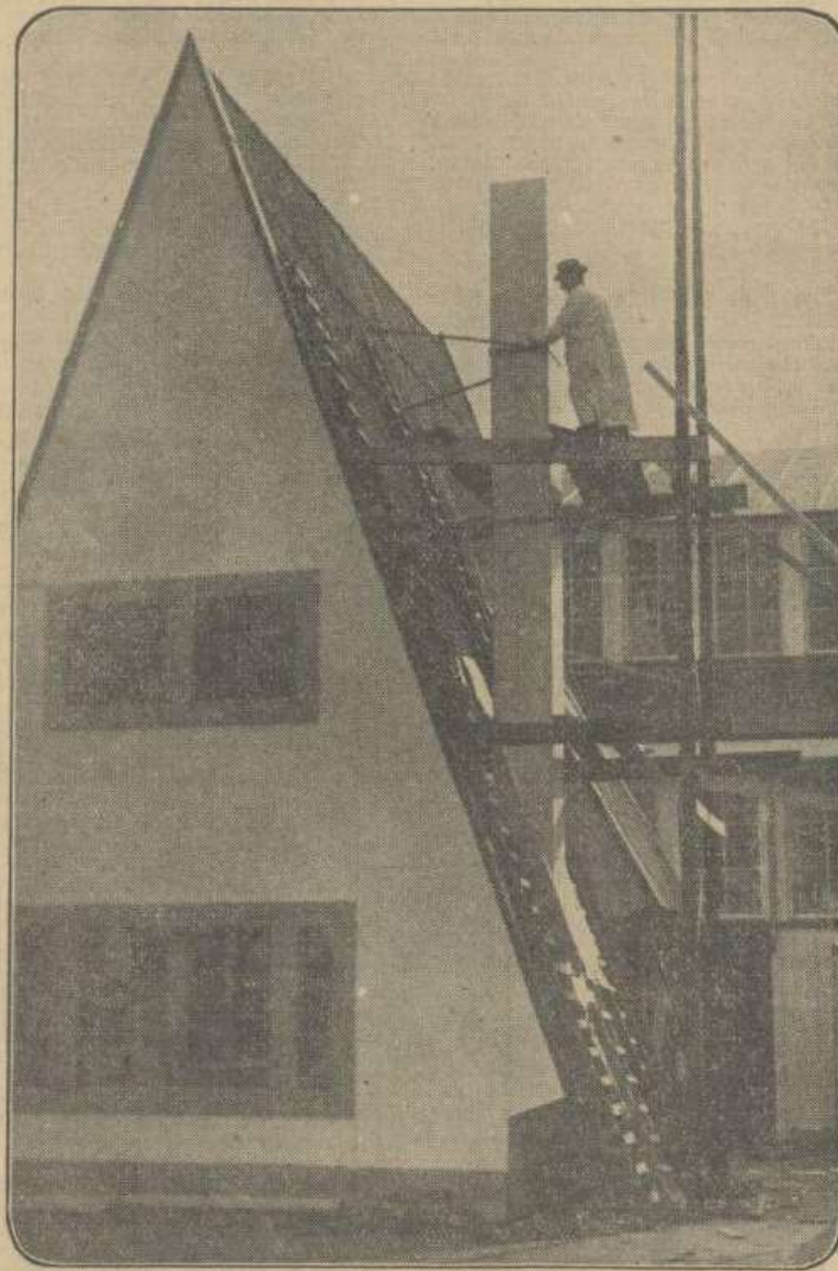
Een huis van asbest zal op de Jaarb'eurs, die de volgende week te Utrecht geopend wordt, geëxposeerd worden. — De opbouw der asbest-woning
