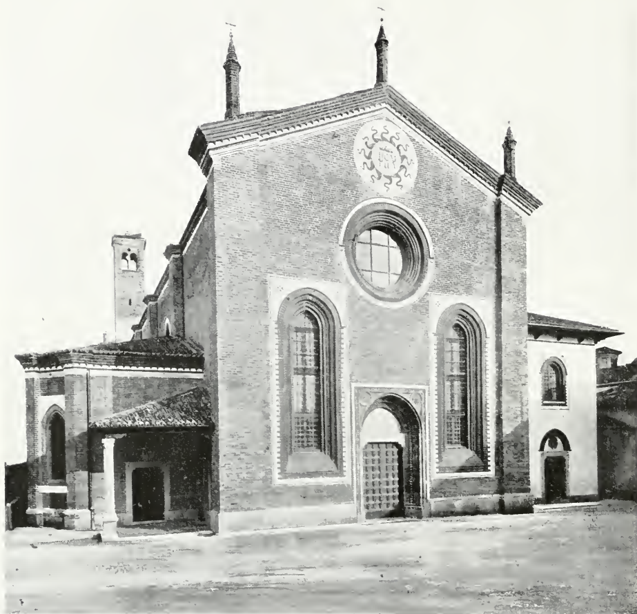
CHIESA DI S. MARIA DELLA PACE DOPO I RESTAURI.
