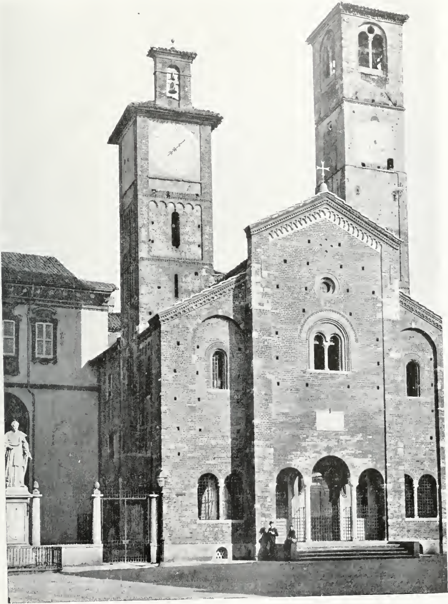
CHIESA DI S. SEPOLCRO, DOPO GLI ULTIMI RESTAURI.
